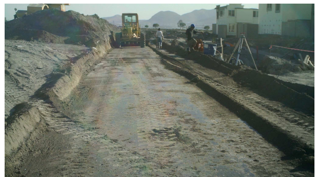
Figura V - 6 Estabilización mecánica por medio de una motoconformadora.
