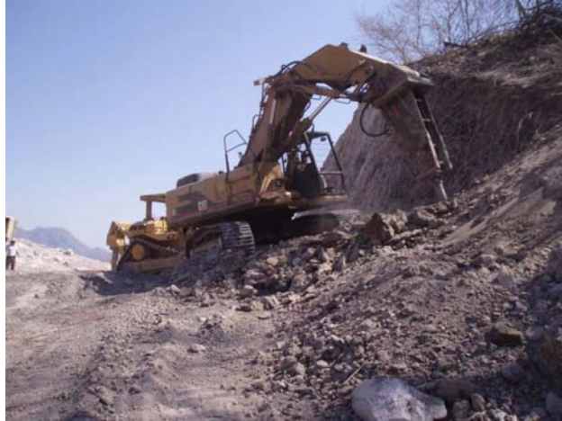
Figura II - 14 Demolición de roca por medio de una excavadora con martillo hidráulico.
