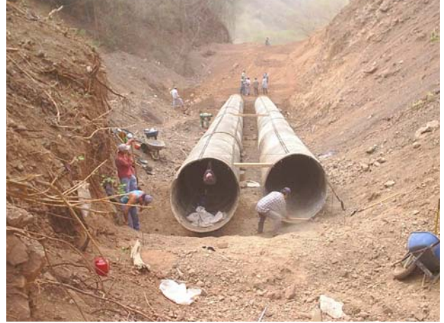
Figura II - 12 Colocación de atiesadores para que no se unan demasiado las tuberías.
