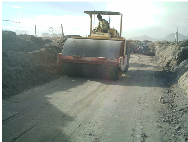
Figura V - 7 Compactación por medio de un vibrocompactador liso.
