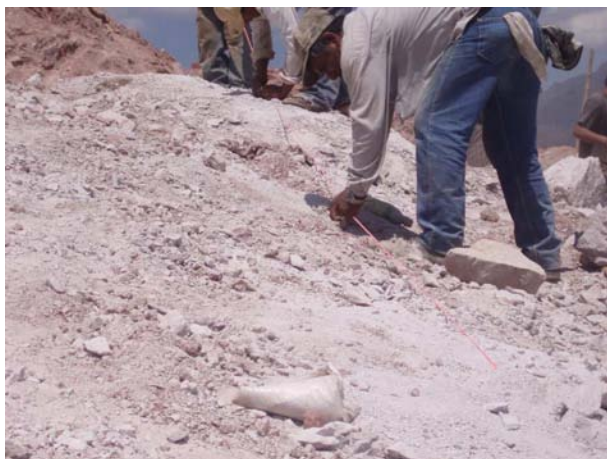
Figura II - 16 Distribución de explosivos.
