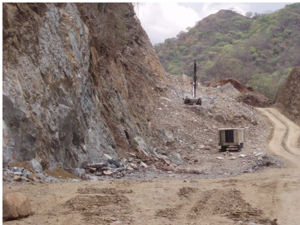
Figura V - 1 Empleo de track drill para la extracción de material para el camino
