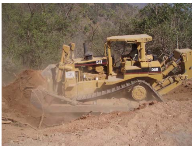
Figura II - 5 Despalse de terreno por medio de tractor de orugas D8R.
