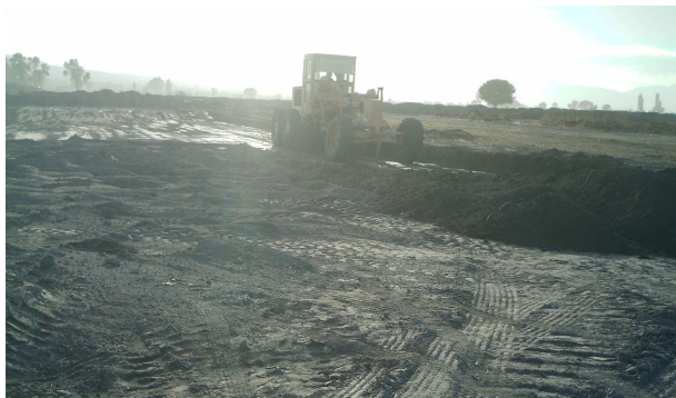
Figura V - 6 Estabilización mecánica por medio de una motoconformadora.
