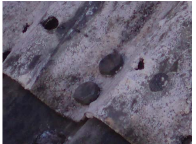
(c) (d) Figura II - 10 Distribución de las láminas(a), para después ensamblarlas (b), ensamble por medio de tornillos (c), (d).
