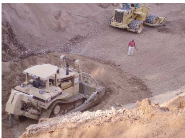
Figura II - 6 Compactación con un rodillo pata de cabra.
