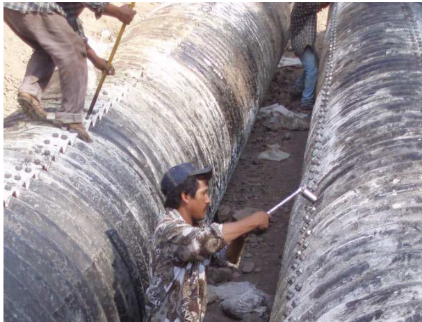
(c) (d) Figura II - 10 Distribución de las láminas(a), para después ensamblarlas (b), ensamble por medio de tornillos (c), (d).
