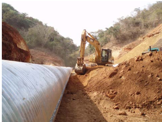
Figura II - 13 Relleno de tubería mediante una excavadora 320.
