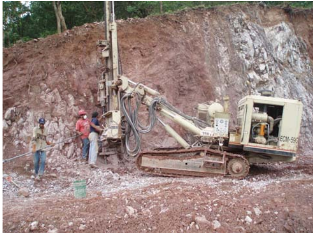
Figura II - 15 “Track drill” realizando trabajos para la realización de cortes, por medio de explosivos.
