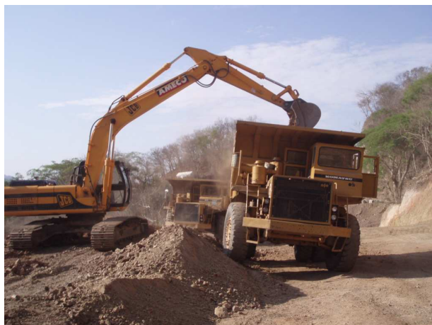
Figura V - 5 Carga y acarreo de material por medio de una excavadora y camiones fuera de carretera.
