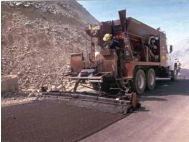
Figura VI - 5 Tendido de mezcla asfáltica por medio de una Finisher.
