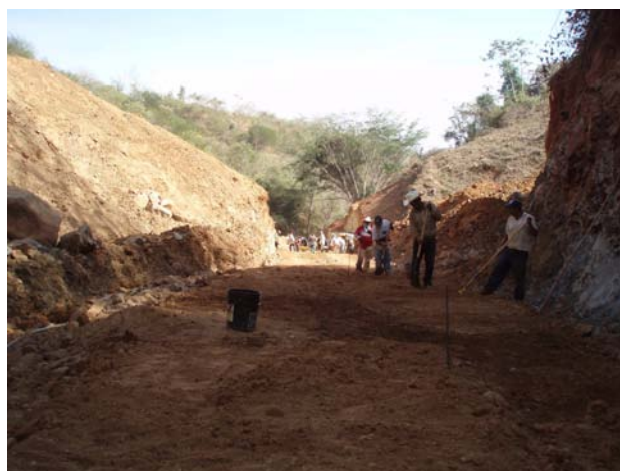
Figura II - 8 Trazo y nivelación de la tubería.
