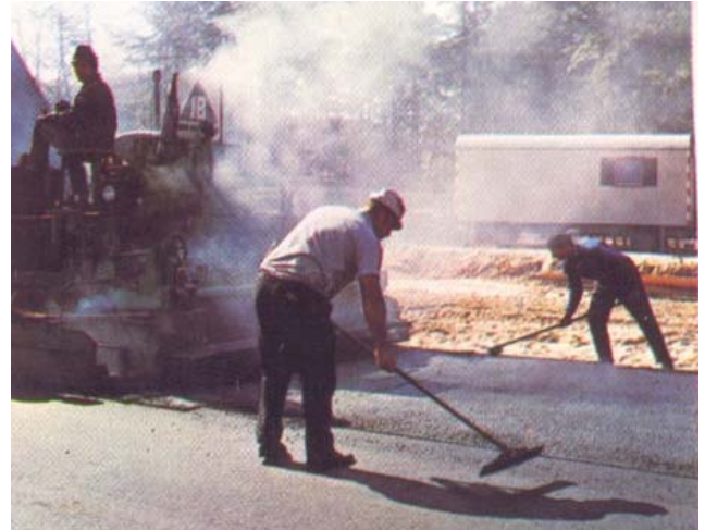
Figura VI - 5 Tendido de mezcla asfáltica por medio de una Finisher.
