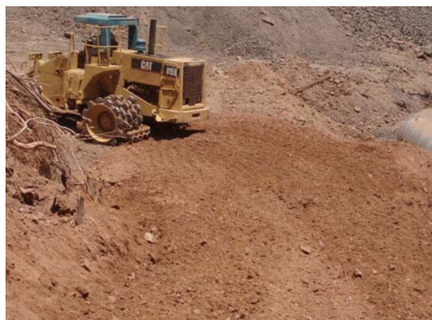
Figura II - 6 Compactación con un rodillo pata de cabra.
