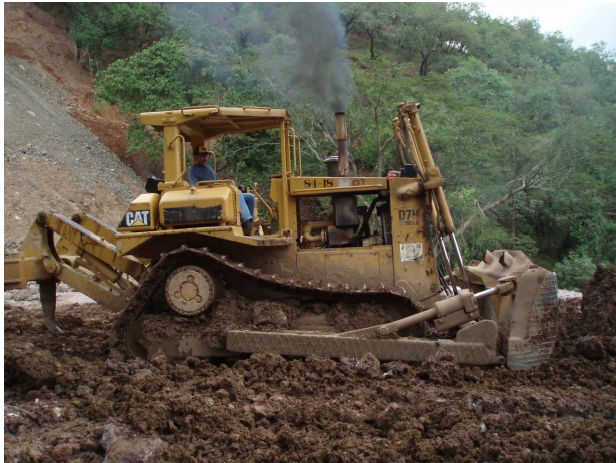
Figura IV - 3 Tractor moviendo material para la capa subrasante
