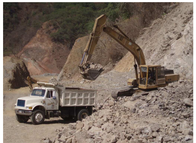
Figura V - 5 Carga y acarreo de material por medio de una excavadora y camiones fuera de carretera.
