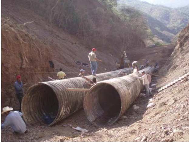
Figura II - 12 Colocación de atiesadores para que no se unan demasiado las tuberías.
