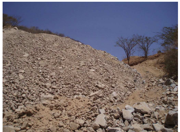
Figura V - 2 Material de banco extraído con ayuda de voladuras.
