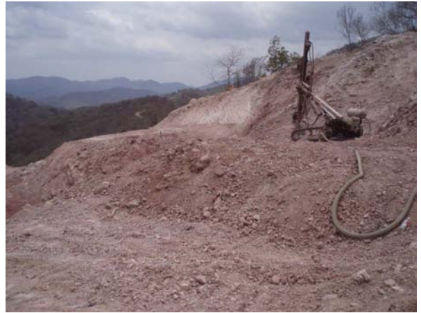
Figura II - 15 “Track drill” realizando trabajos para la realización de cortes, por medio de explosivos.
