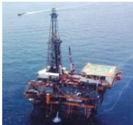
Figura 1.10 Plataforma de perforación fija de 8 piernas (Octápodo).
