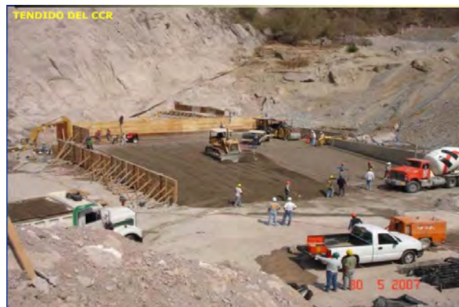
6.7 Tendido de CCR por medio de tractor de oruga
