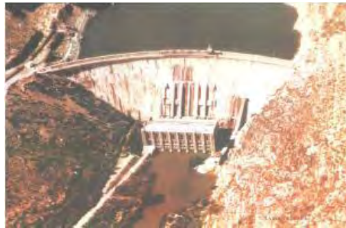
Fig.2.Presa de contrafuerte de concreto, Hidroeléctrica la boquilla
