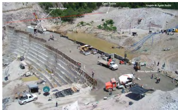
Fig. 6.1 Construcción de la presa Picachus
