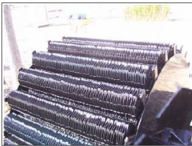
Figura 2-12.- Discos biológicos rotatorios.
