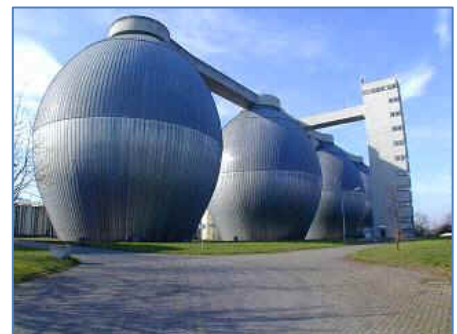
Figura 2-30.- Dispositivo para la estabilización de lodos.
