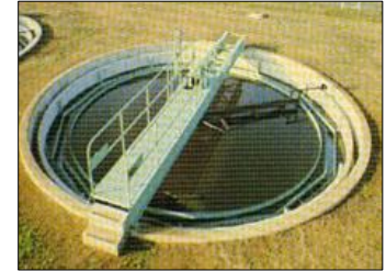
Figura 2-10.- Sedimentador circular.
