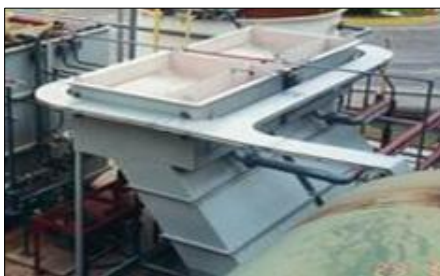
Figura 2-9.- Sedimentador tipo Lamella.
