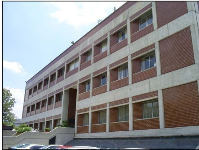
Figura B-1.- Edificio 12 del Instituto de Ingeniería de la UNAM.
