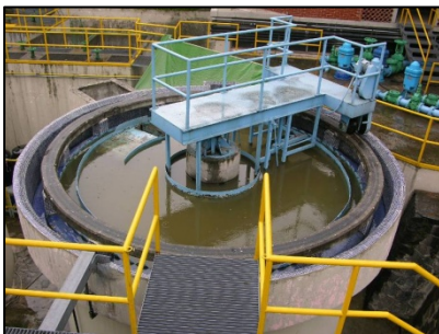
Figura 2-16.- Tanque de lodos activados.
