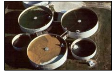
Figura 2-17.- Reactores batch secuenciales.
