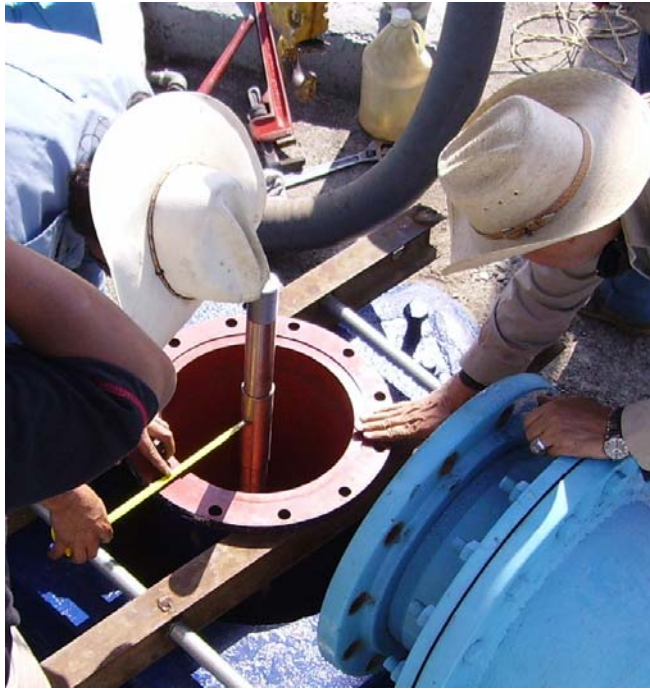
Fig. 1.2.5 Medición de diámetro de columnas de succión del cárcamo de bombeo.
