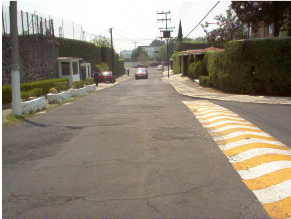
SITIO DE PROYECTO DE POZO DE ABSORCIÓN 3
