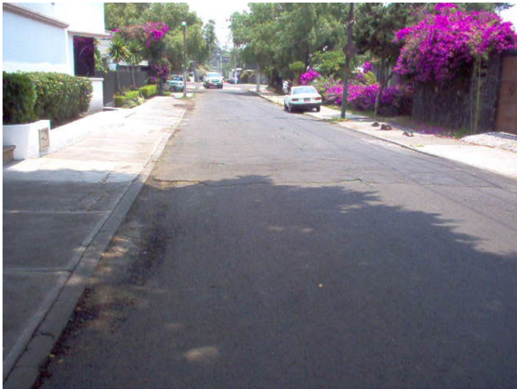
SITIO DE PROYECTO DE POZO DE ABSORCIÓN 4
