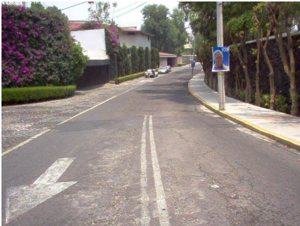
SITIO DE PROYECTO DE POZO DE ABSORCIÓN 2
