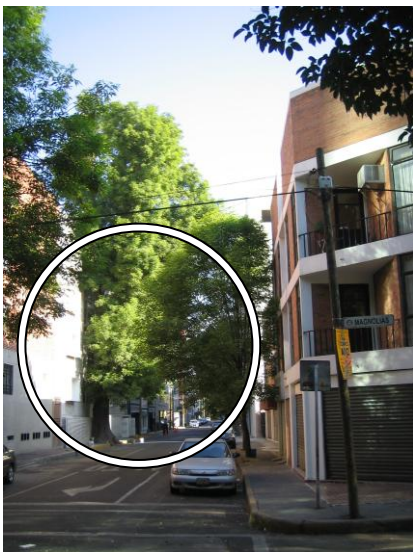
Las raíces y fronda de los árboles se ve seriamente afectada por las nuevas construcciones
