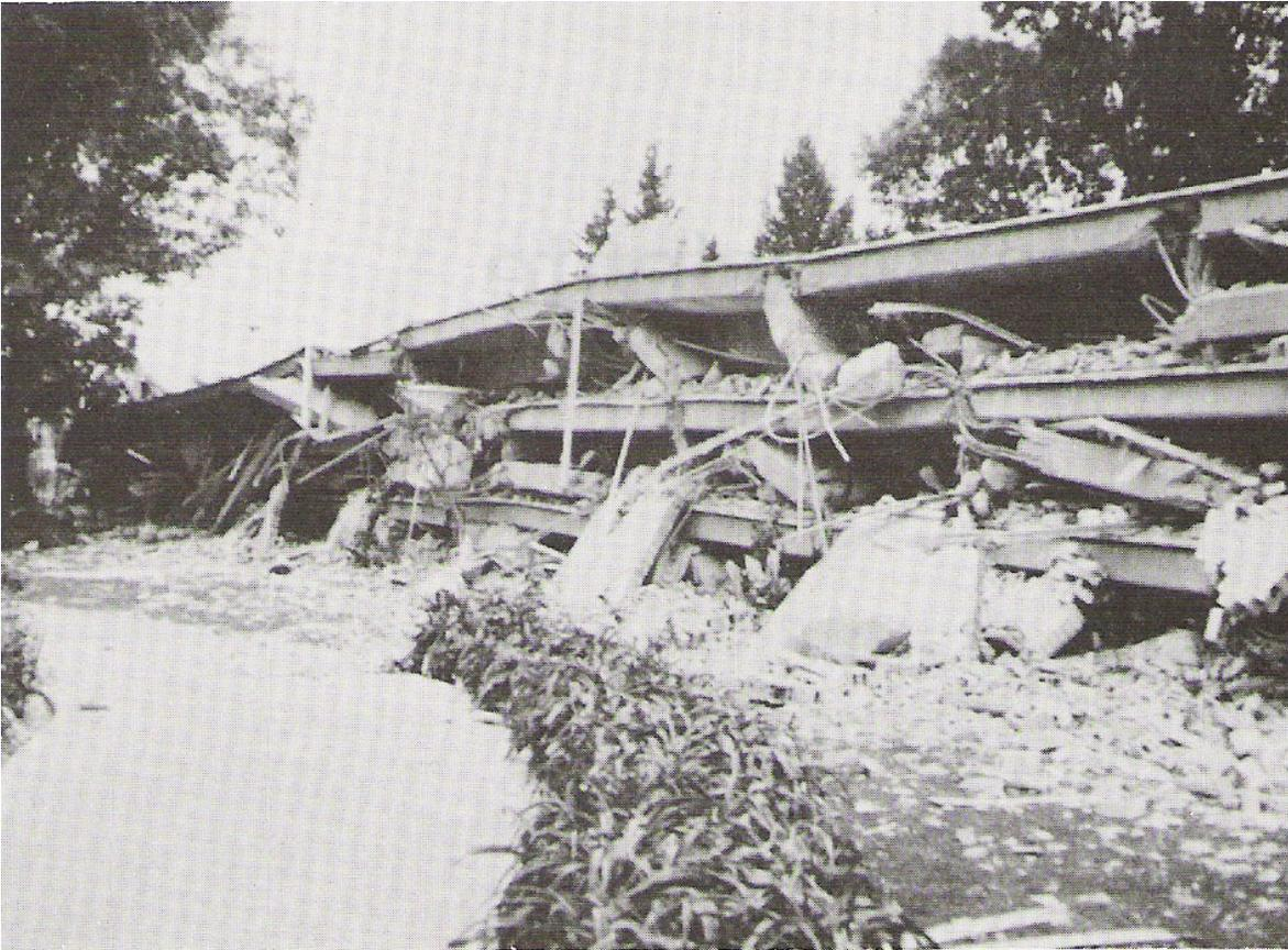
Fig. IV.1 Colapso de un edificio a causa de un sismo (Ciudad de México, 1979).
