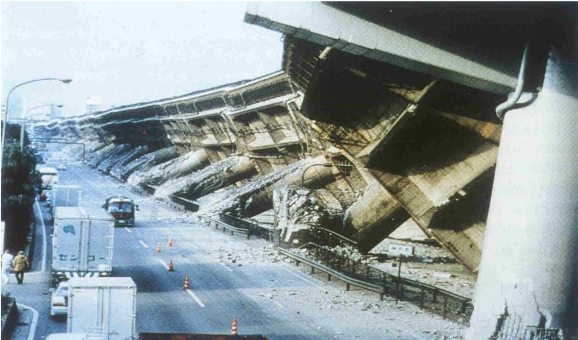
**Fig. I.4 Autopista elevada averiada por el terremoto de Kobe en dirección transversal.**
