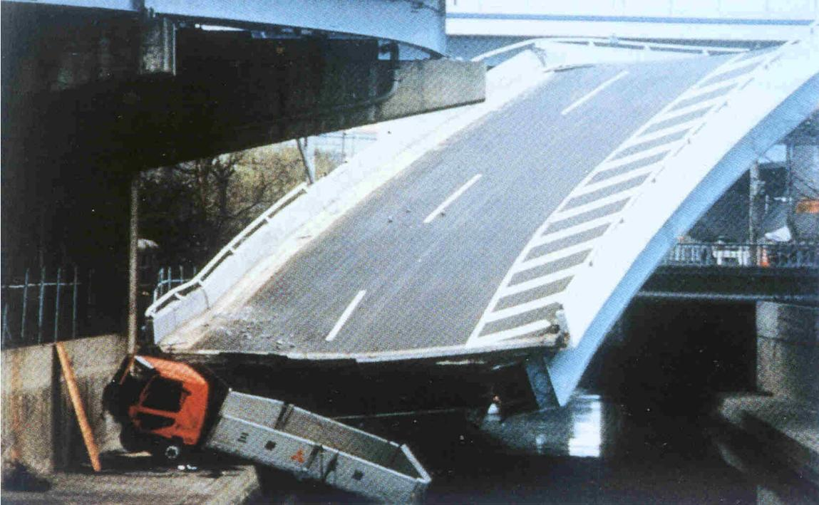
Fig. I.5 Autopista elevada averiada por el terremoto de Kobe en dirección longitudinal.
