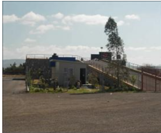
Foto 32. Estación de transferencia intermunicipal de Pabellón de Arteaga.
