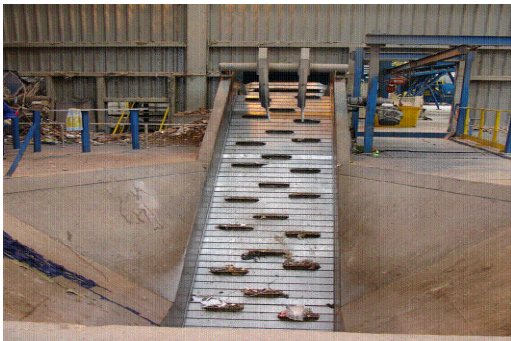
Foto 35. Sistema de bandas para procesamiento de RSU
