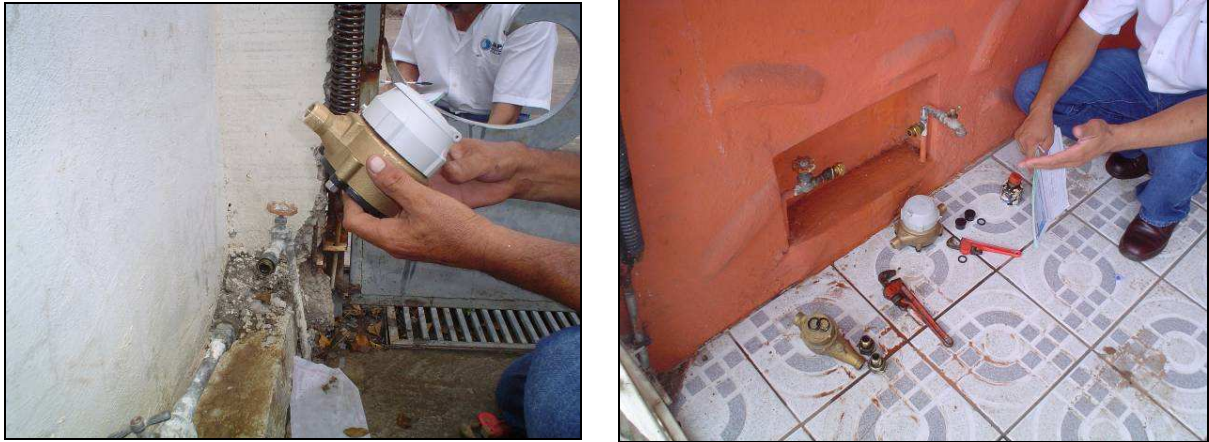
Ilustración 4.6. Instalación de micromedidores volumétricos nuevos dentro del sector Humaya
