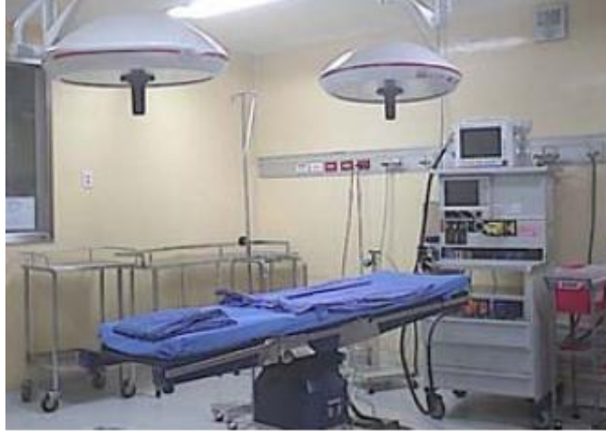
Fig. 2.8 Sala de operaciones.
