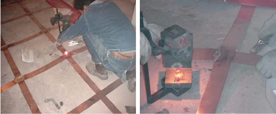
Fig. 4.9 Colocación de piso semiconductor.
