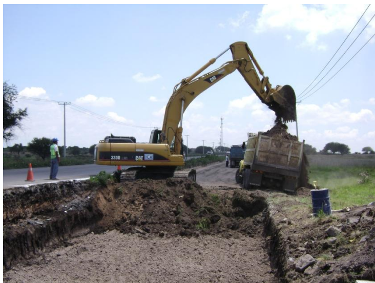
Fig. 88 Excavadora 330DL excavando y llenando camión de volteo.
