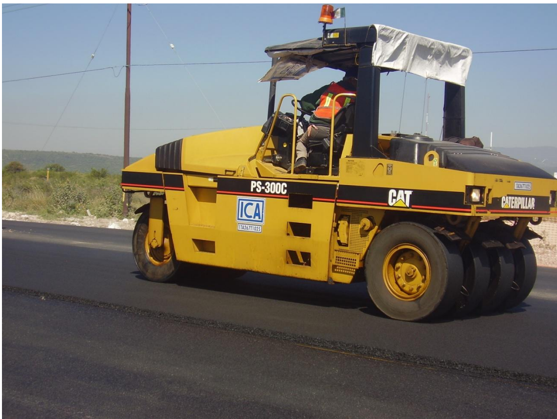
Fig. 80 Compactador PS-300C en trabajos sobre la carretera Querétaro - Irapuato.
