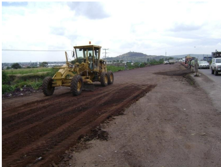
Fig. 75 Motoconformadora en construcción de caminos.
