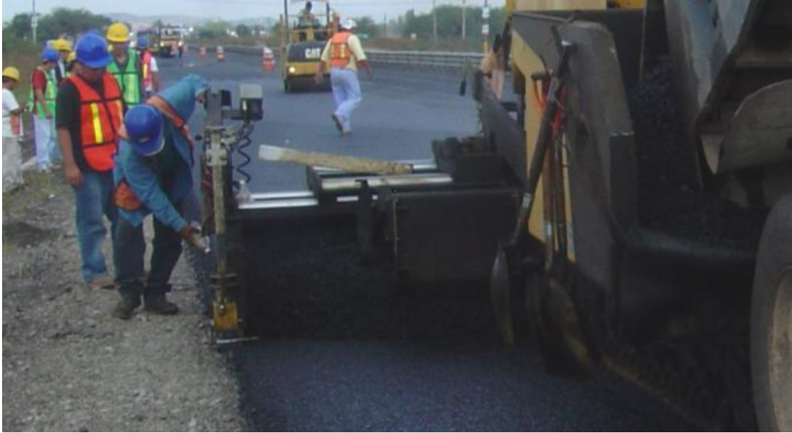
Fig. 19 Nivelación del tendido de asfalto.
