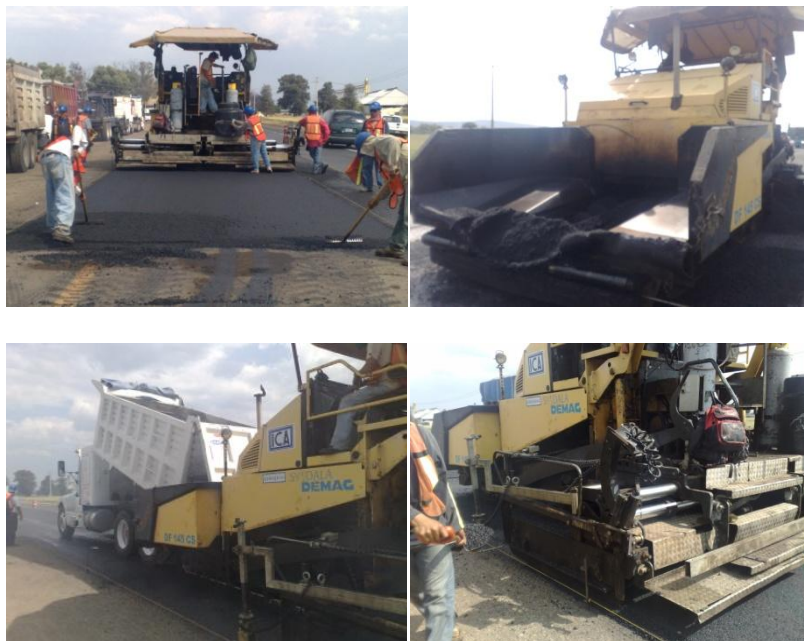
Fig. 68 La primera imagen muestra a los rastrilleros ejecutando su trabajo después de que pasa la extendedora de asfalto; la segunda imagen muestra la parte de descarga del asfalto; en la tercera se muestra el vaciado de asfalto y en la cuarta se muestra el sistema de nivelación de la extendedora.
