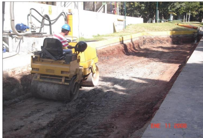
Fig. 34 Rodillo vibrador compactando la base de una calle.
