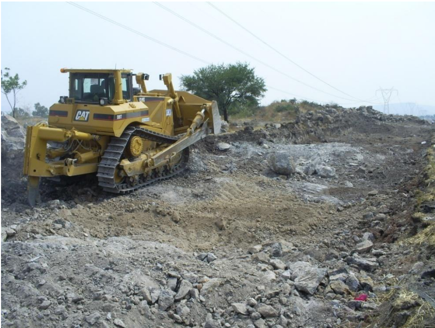
Fig. 74 Tractor D8T extendiendo material.
