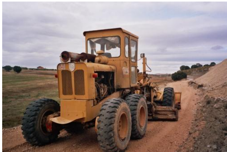
Fig. 27 Construcción de caminos.
