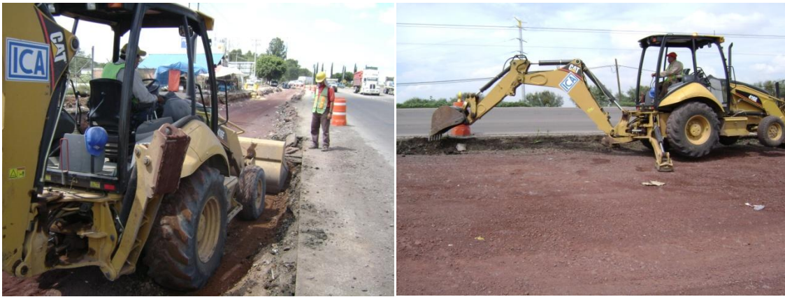
Fig. 85 Retroexcavador en trabajos de excavación y corte de material.
