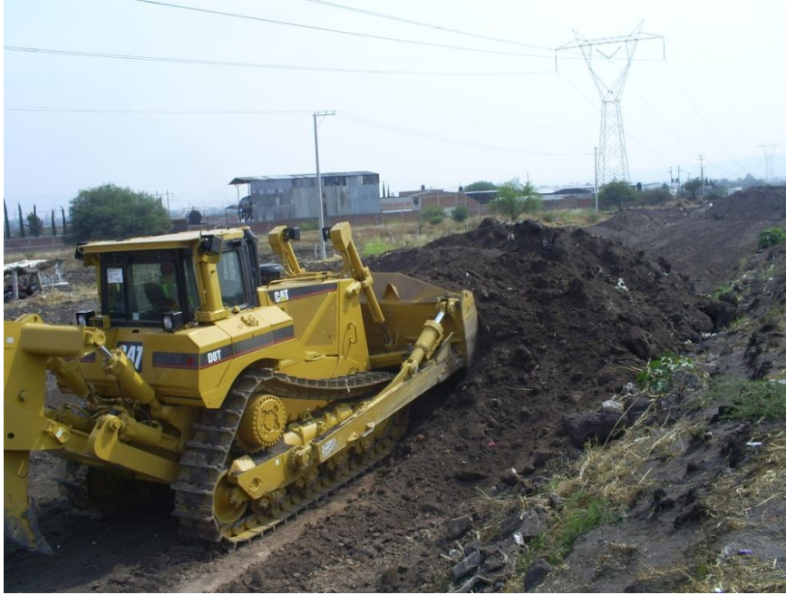
Fig. 73 Tractor D8T en empuje de material de excavación.
