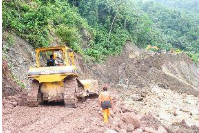
Fig. 23 Tractor de orugas en construcción de caminos.
