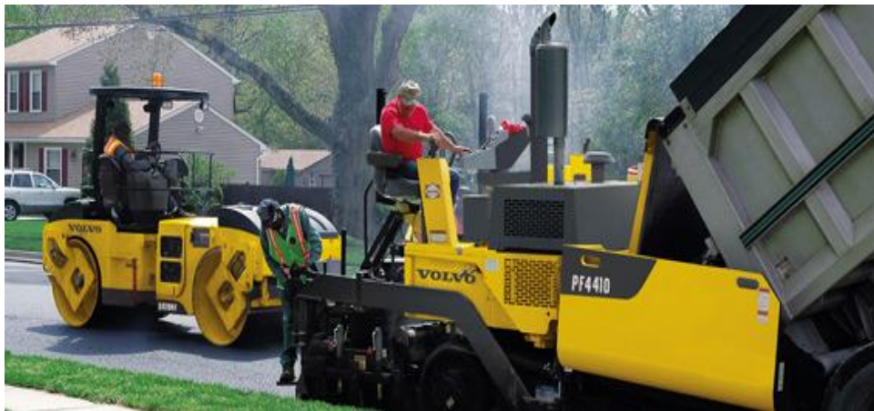
Fig. 18 Tren de colocación de asfalto.
