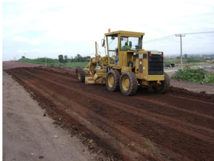
Fig. 76 Motoconformadora nivelando carretera.
