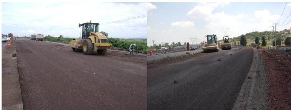
Fig. 78 Trabajos de compactación de asfalto y terracerías.
