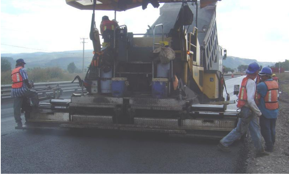
Fig. 16 Pavimentadora de asfalto.
