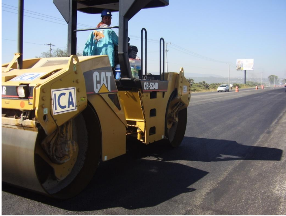
Fig. 79 Compactadora en trabajos sobre asfalto.
