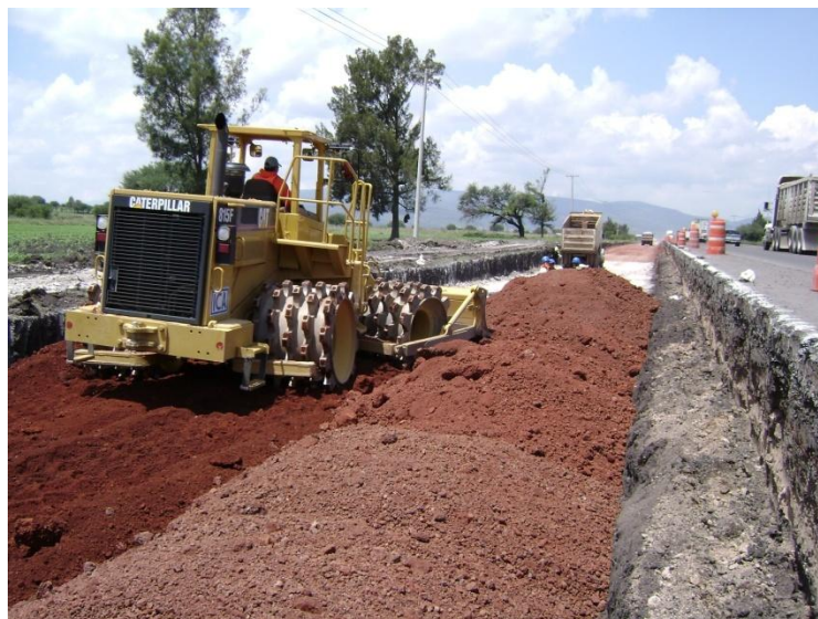
Fig. 82 Compactador pata de cabra sobre suelo de base.
