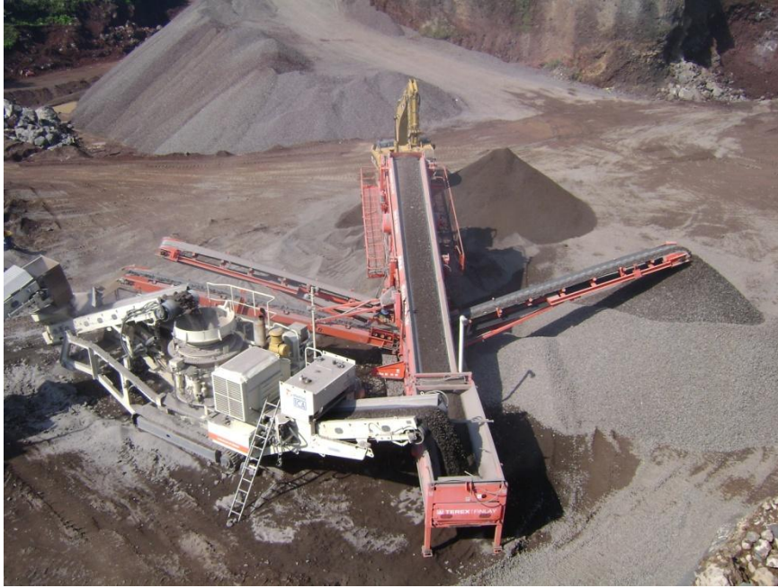
Fig. 90 Planta de trituración utilizada en el proyecto.
