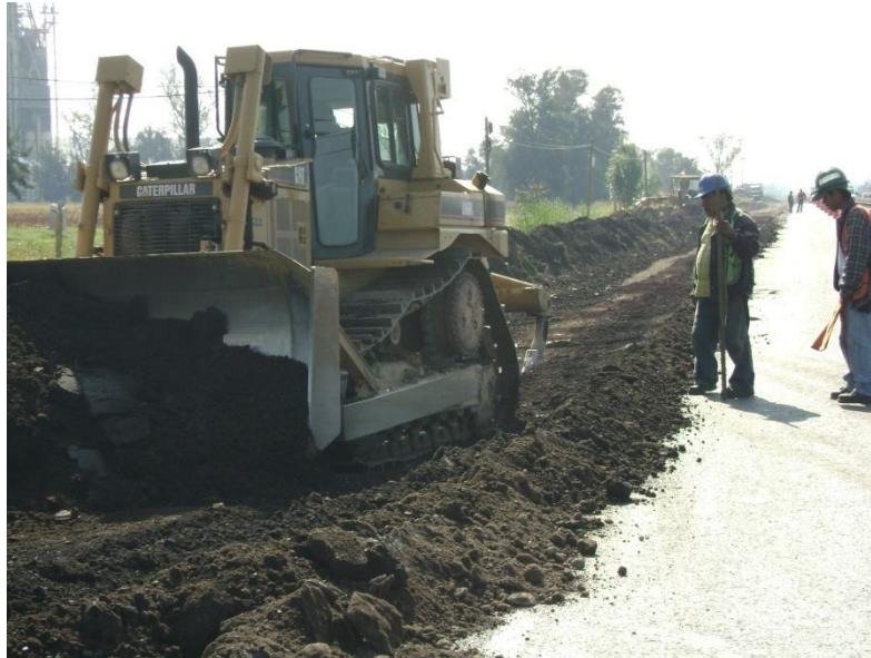
Fig. 71 Tractor D6R III en empuje de tierras.
