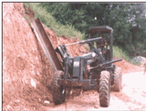
Fig. 25 Afine de taludes.
