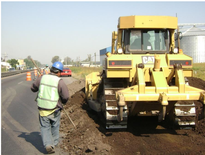
Fig. 72 Tractor D6R III en desempalme de suelos.
