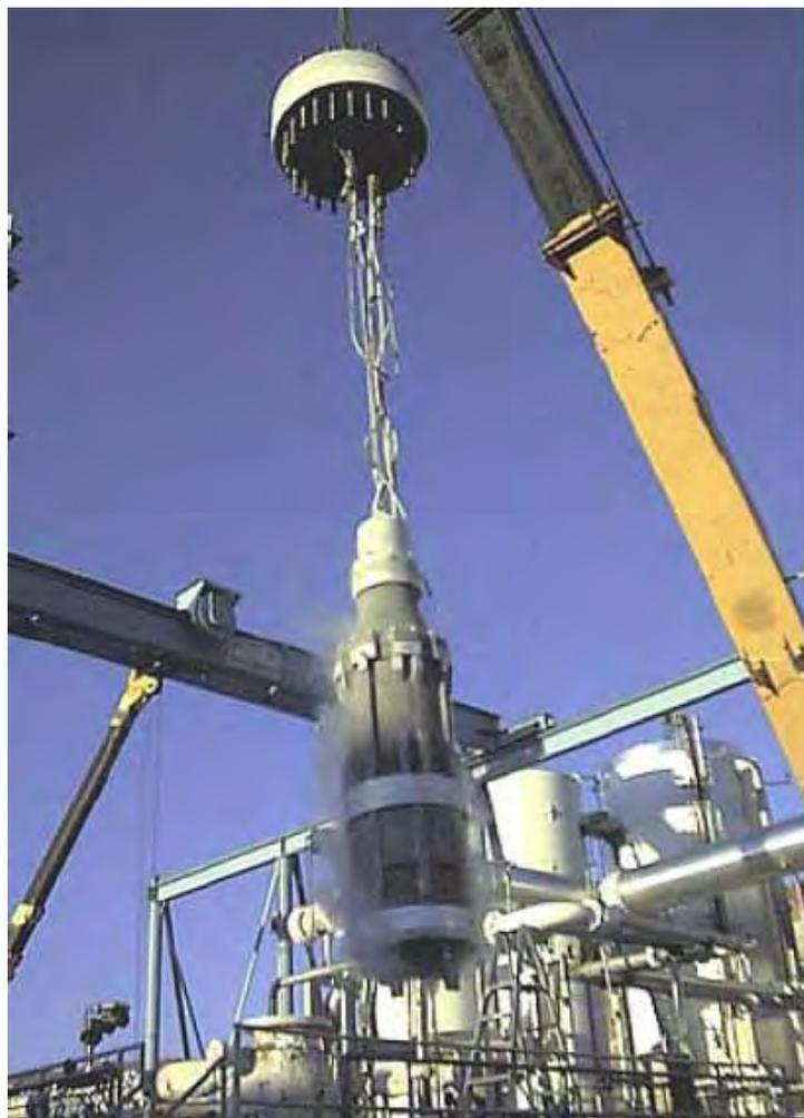
Figura 1.14 Recondensador
