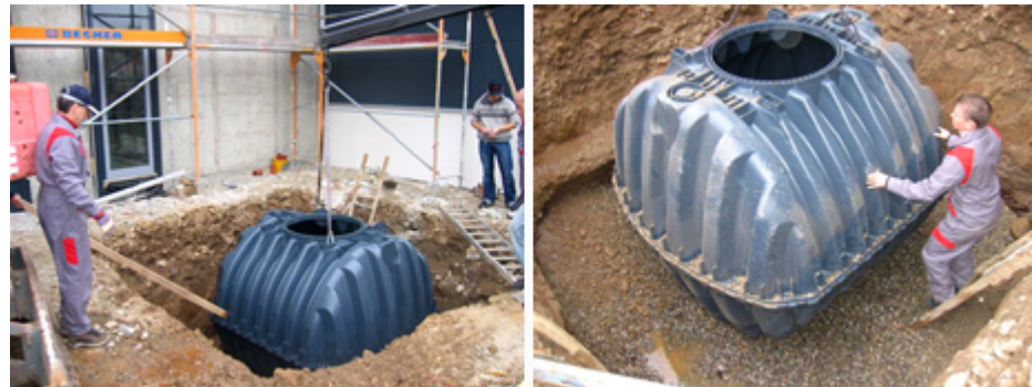
Colocación del tanque bajo tierra
