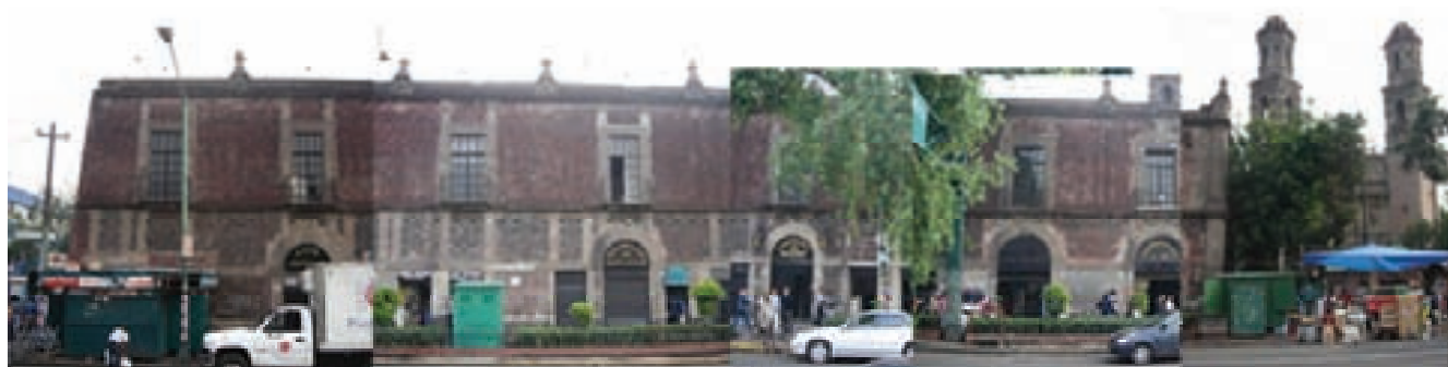
Ex Convento e Iglesia de San Hipólito (Av. Hidalgo entre Héroes y Zarco).
