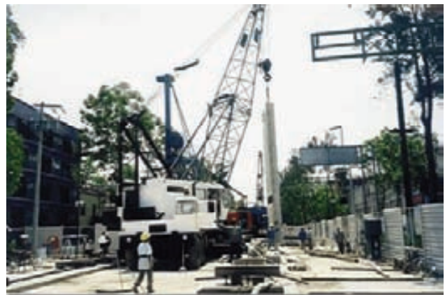
Construcción de la Línea B del Metro (Fotografía de http://www.tecnosuelo.com.mx )
