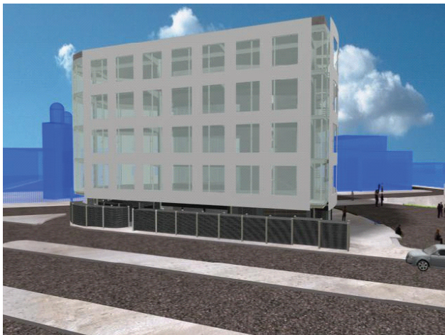
Edificio de Oficinas desarrollado en 5 niveles. Comercio en Planta Baja y los cuatro Posteriores de Oficinas
