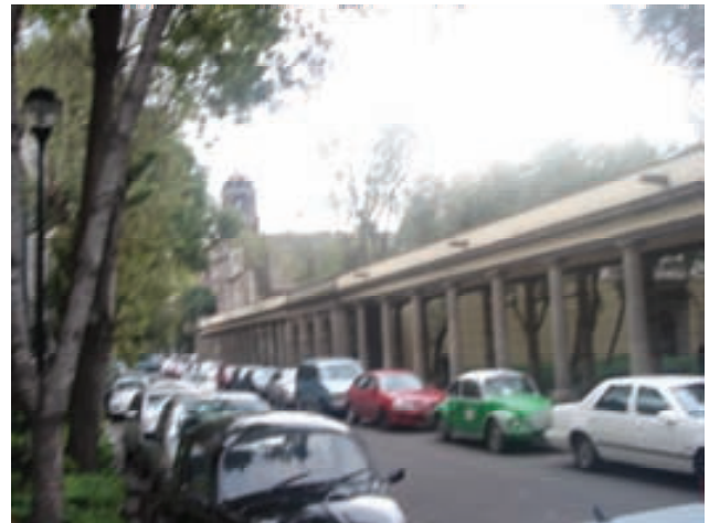
Portico del Panteón de San Fernando (Fotografía tomada en el sitio)
