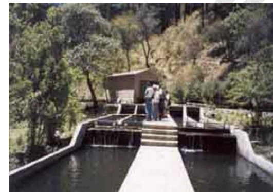
PLANTA DE TRATAMIENTO DE AGUAS
