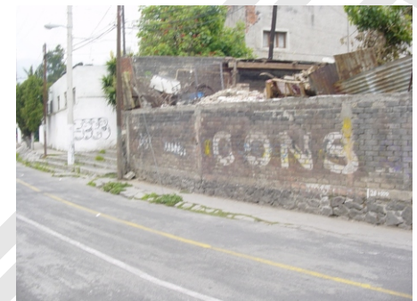
Foto 8.- El deterioro de la misma banqueta provoca que el peatón ande por la avenida.
