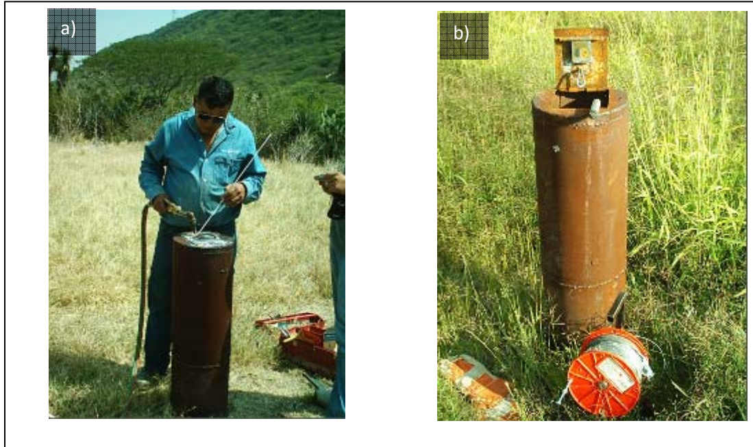
Figura 13. a) Instalación de puerta y cerradura al ademe del pozo, b) Instalación del sensor sostenido con cable acerado de 1/8".
