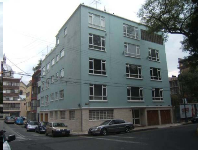
Vista 4 Terreno fachada sur-oeste
