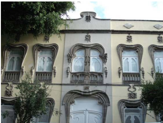
Edificio Chihuahua 78, con claros detalles art nouveau en las molduras que envuelven los vanos de las puertas y ventanas.
