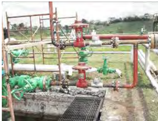
Fig. 4.25 Instalación de líneas superficiales para el sistema de extracción de líquidos en el pozo Muspac 2, (Shaip, 2007 2 ).
