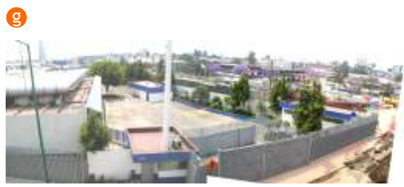
Vista desde Circuito Interior hacia el estacionamiento
