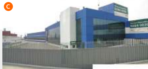
Vista desde Río Consulado hacia el volumen de mayor altura (15m aprox.) del conjunto
