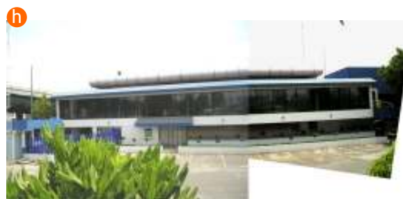
Fachada Sur desde el interior del predio (alineamiento)
