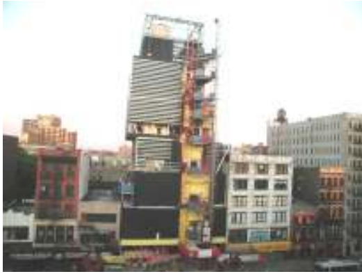
En etapa de construcción junio 2007
