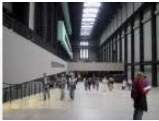
Sala de turbinas
