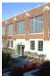
Vista hacia el acceso
