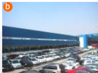
Vista fachada norte y estacionamiento
