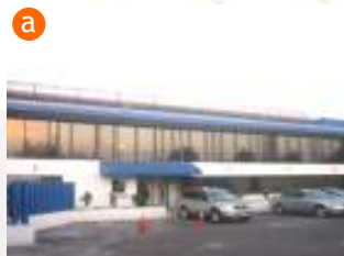
Vista de fachada sur desde el interior del terreno
