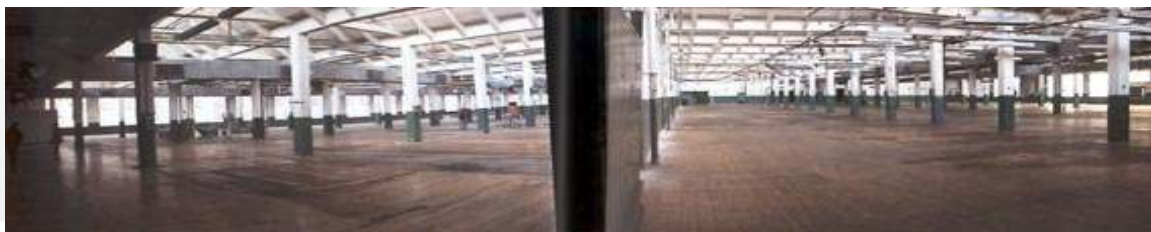
Vista durante intervención de la antigua fábrica
