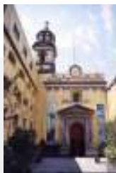
Actual fachada principal
