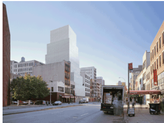
Vista de la fachada sur
