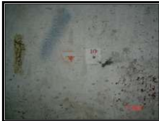
Fig. 5.28 Fotografía de las marcas de nivelación para columnas.
