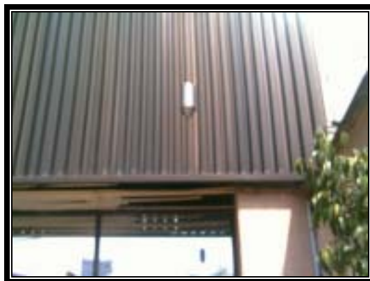
Fig. 7.3 Fotografía de la polea de la Plomada Física (esquina Sur-Ete).
