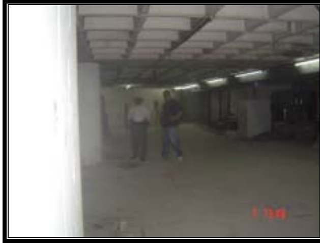
Fig. 7.31 Fotografía de los trabajos en el sótano.
