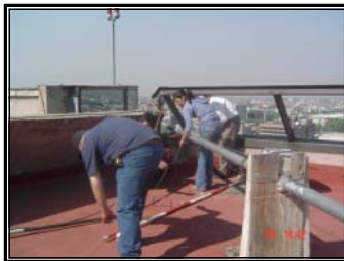
Fig. 7.2 Fotografía de la rehabilitación de las plomadas existentes.
