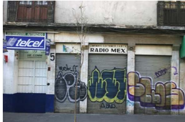
Los vándalos aplican en cualquier paramento sin importar el material o acabado de las fachadas. En esta imagen la pinta es sobre un simulado de tezontle a base de mortero cemento-arena, lo que no representa grave daño, pero la pilastra de la derecha que es de mármol presenta residuos de pintas.
