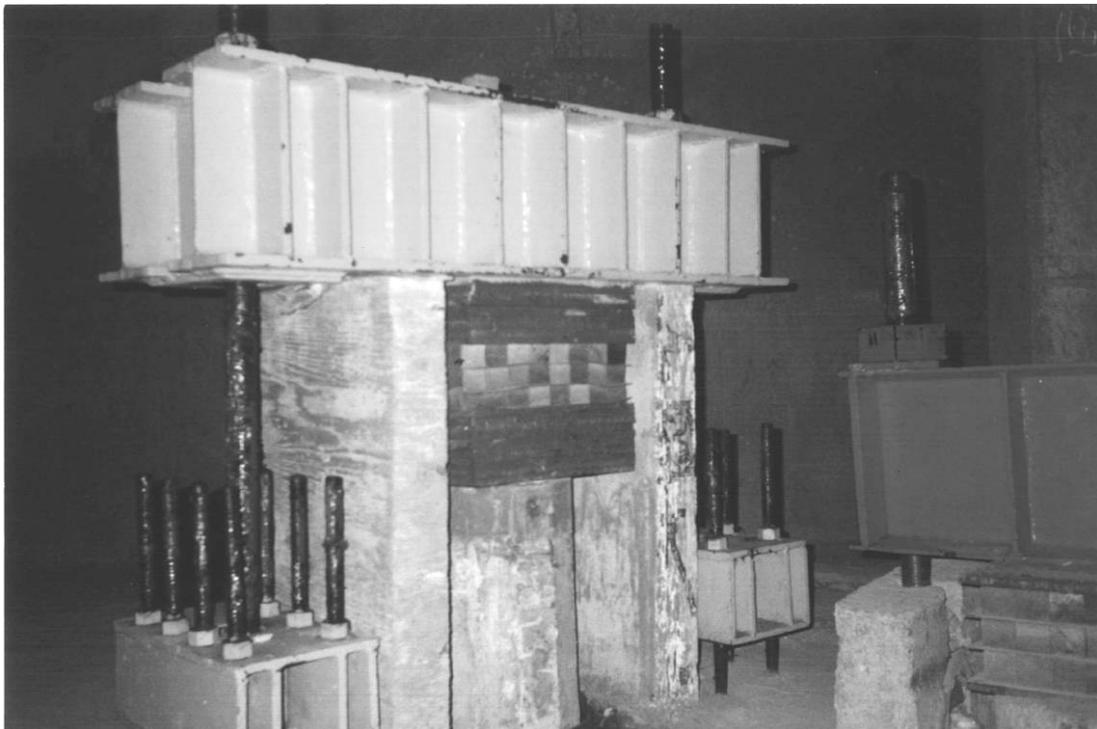
Pilotes de control para ir nivelando el hundimiento diferencial de la Catedral.
