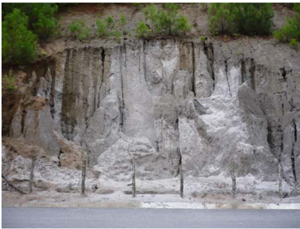
Foto IV.12. Evidencia de un antiguo deslizamiento translacional en las ignimbritas Xaltipan (año 1999) que destruyó la carretera (ya fue reconstruida).
