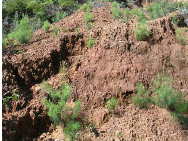
Foto III.1. Depósito de coluviones expuesto por un deslizamiento translacional ocurrido cerca de la carretera que va de La Unión a Atotocoyan.
