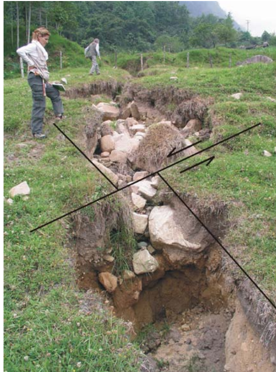
Foto II.11. Falla normal izquierda con orientación N 20° que se produjo en 2005 afectando un talud gravitacional.
