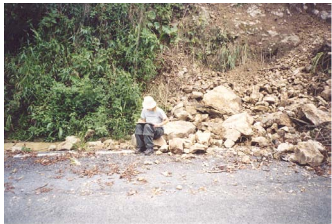
Foto IV.5. Depósito de detritos Cerca del poblado de San José Chagchaltzin, este tipo de flujo de detritos se encuentra en casi todas las carreteras de la zona en estudio.
