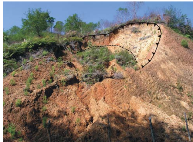
Foto IV.3. Deslizamiento translacional en material de coluviones en la carretera que va de La Unión a Atotocoyan. En la cabecera aparece una coronación con cicatrices de arranque (en negro) y en la masa desplazada se reconocen bloques.
