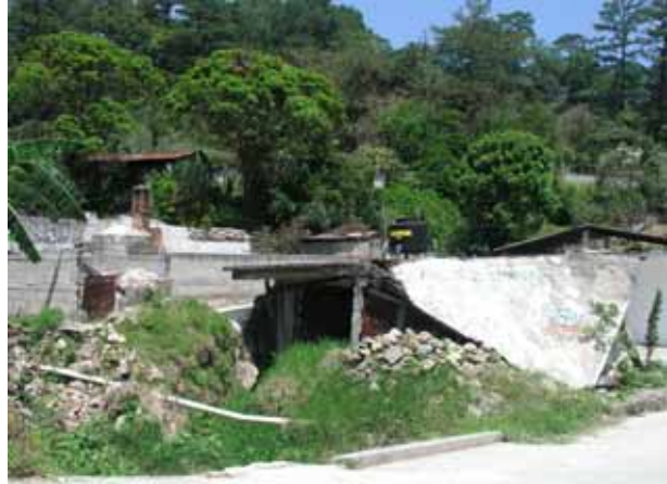
Foto VI.3. Casas destruidas por la avalanchas de rocas ocurrida en 1999.
