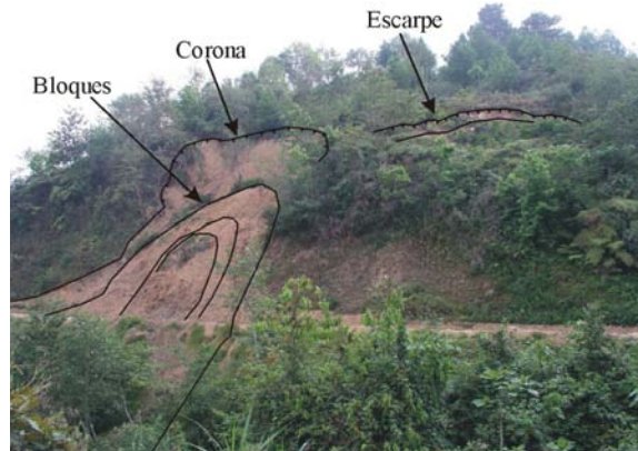
Foto. IV.7. Deslizamiento translacional en la unidad geológica JI. Se encuentra en el tramo de la carretera que va de San José Chagchaltzin y San Agustín Chachlatzin
