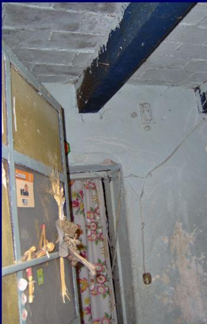
□ Foto No. 14 (interior vivienda )
