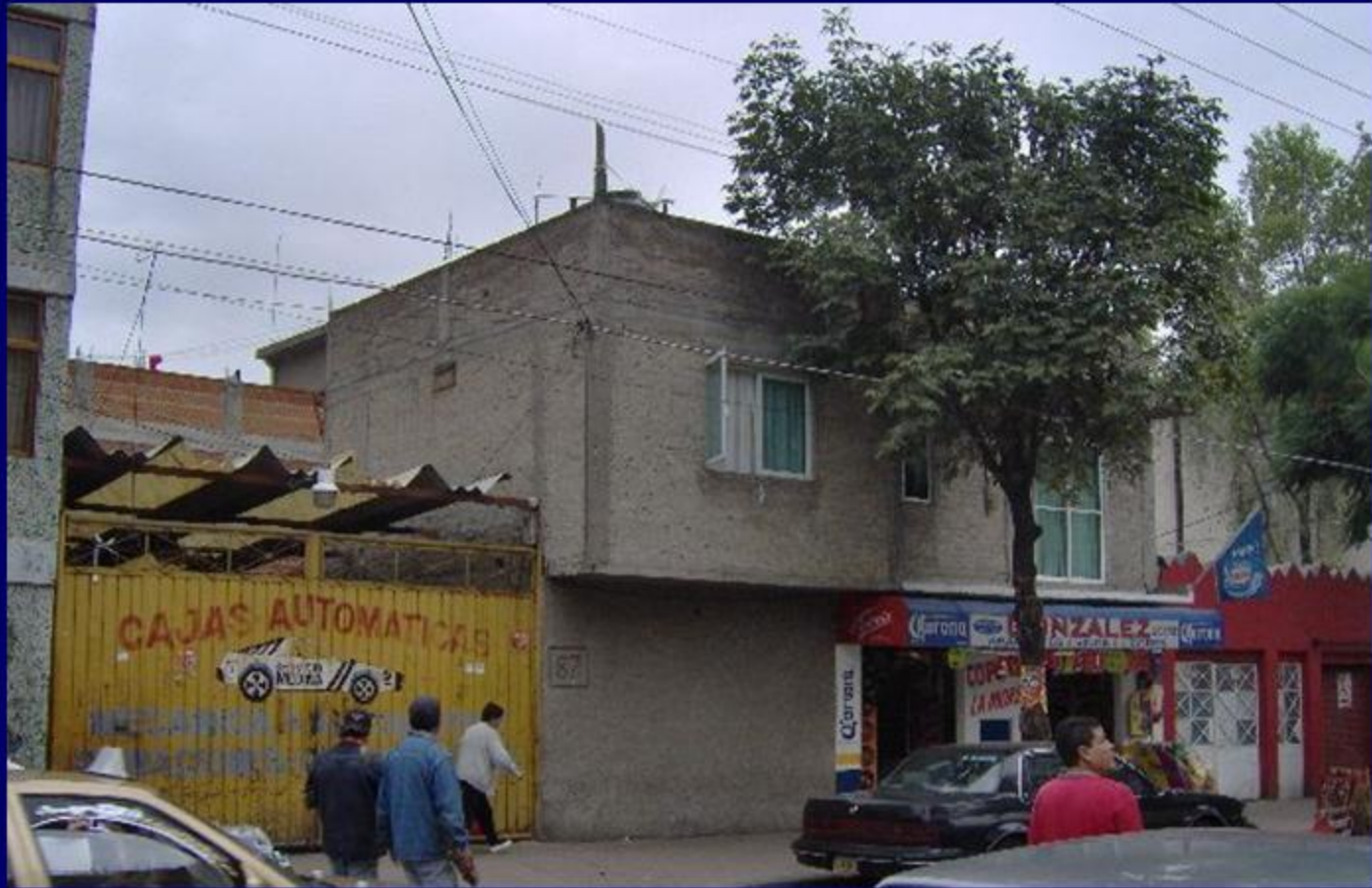
Ampliación y Mejoramiento en fachada
