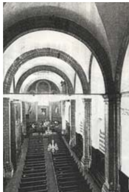
Imagen 47 Vista de la nave central y altar principal. Fotografía circa 1900.
