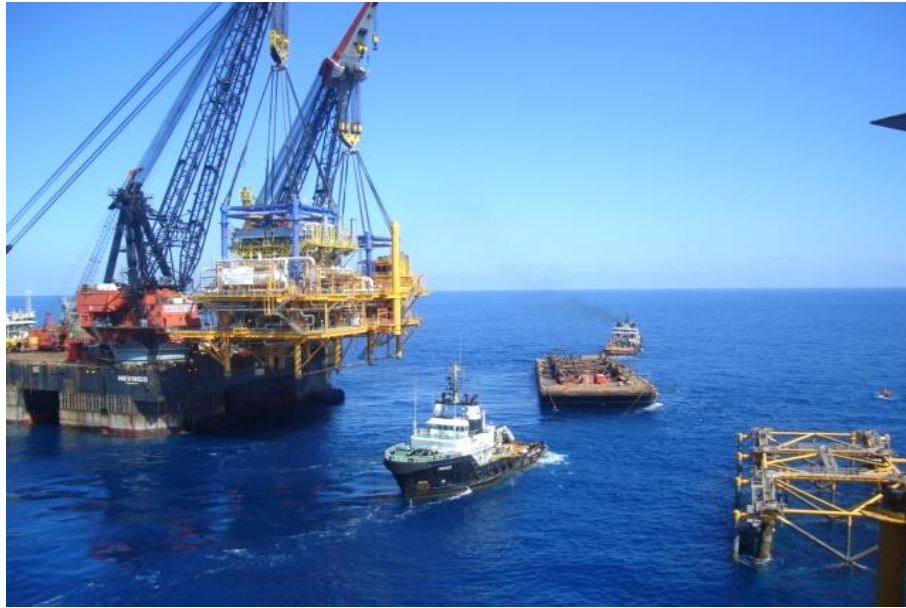
Ilustración 26. Aproximación de barco grúa a la subestructura
