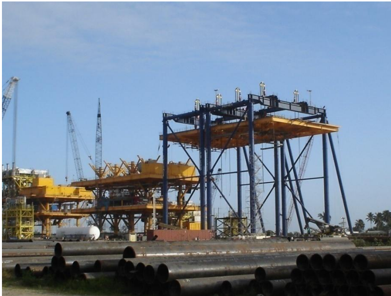
Ilustración 25. Izaje de la cubierta superior a la altura necesaria para poder colocar las otras 2 cubiertas
