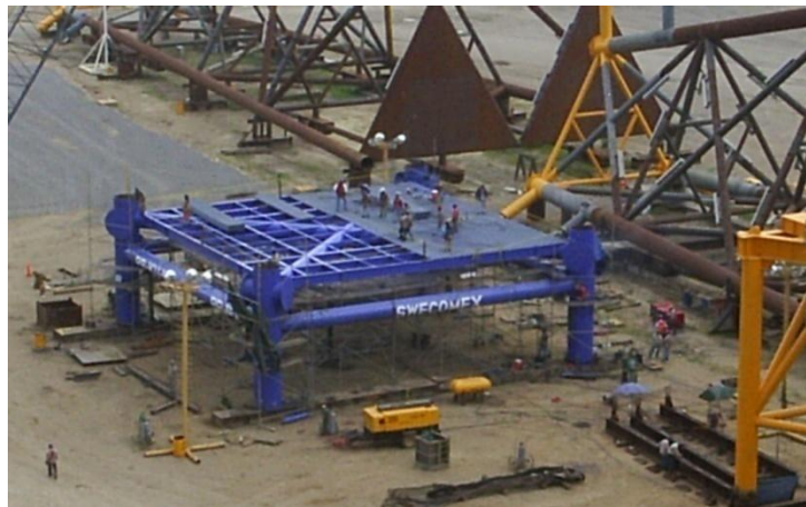
Ilustración 23. Arreglo de izaje
