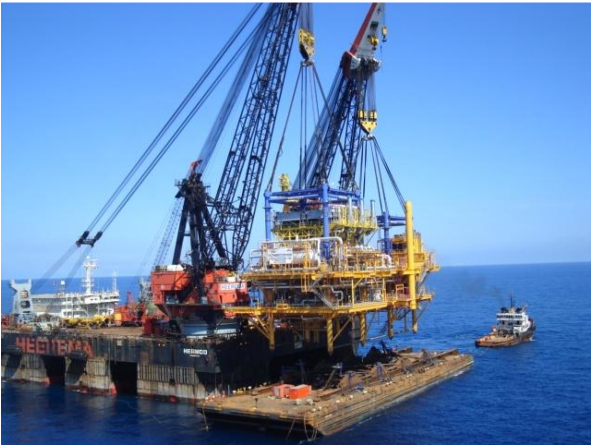
Ilustración 25. Izaje de una superestructura para su instalación
