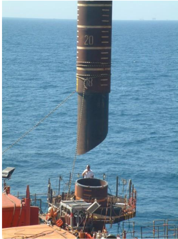
Ilustración 20. Primera sección de un pilote posicionándose para ser hincado
