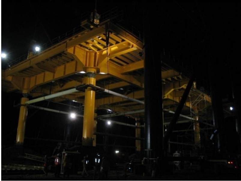
Ilustración 16. Colocación de la cubierta inferior sobre las columnas
