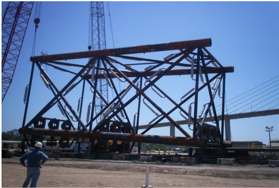
Ilustración 28. Inicio de la maniobra de izaje de la subestructura
