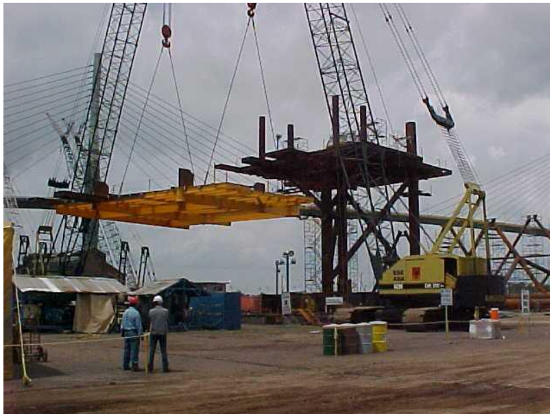
Ilustración 33. Izaje de la cubierta
