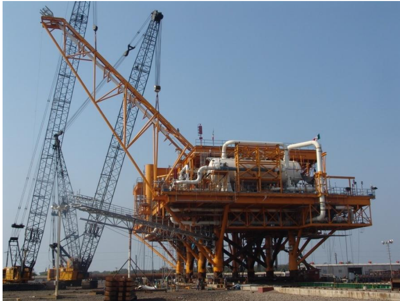
Ilustración 14. Superestructura terminada en un patio de fabricación
