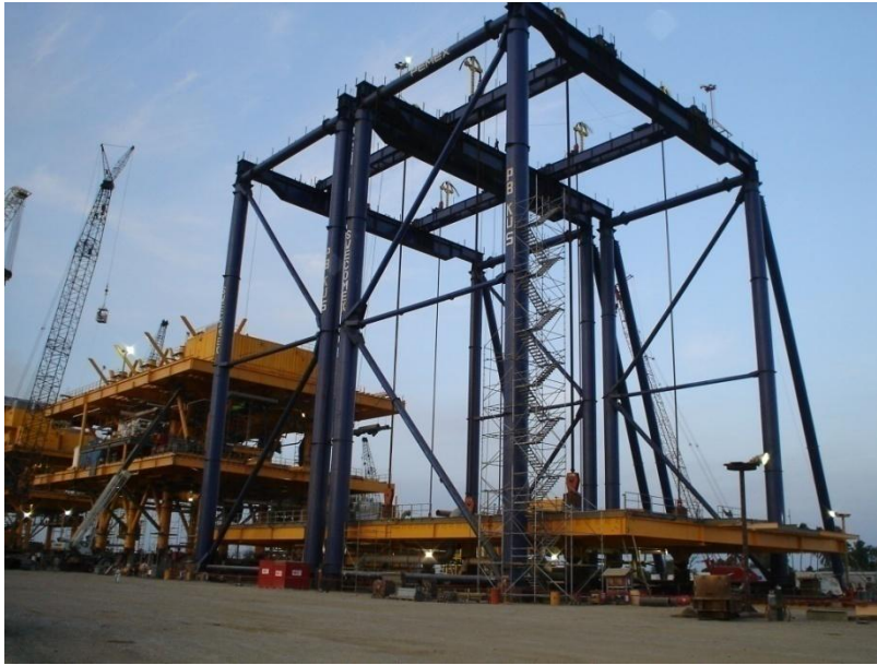
Ilustración 24. Inicio del izaje de la cubierta superior
