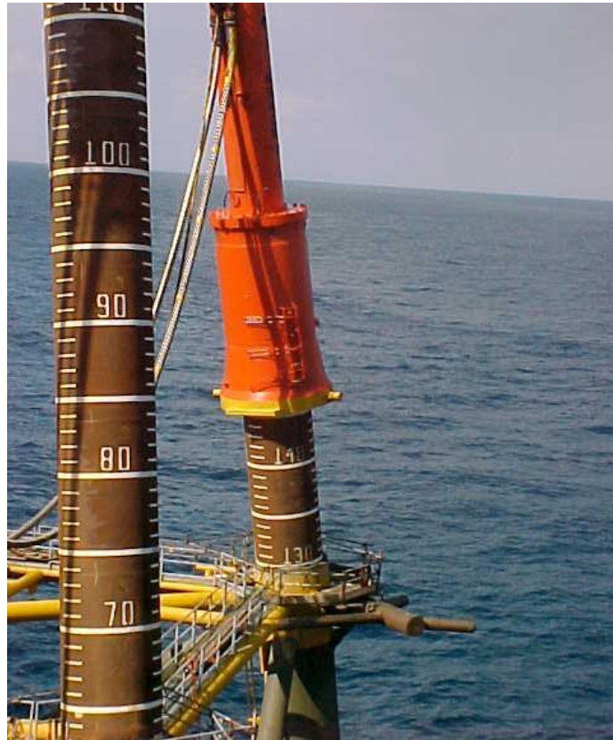
Ilustración 21. Hincado de un pilote
