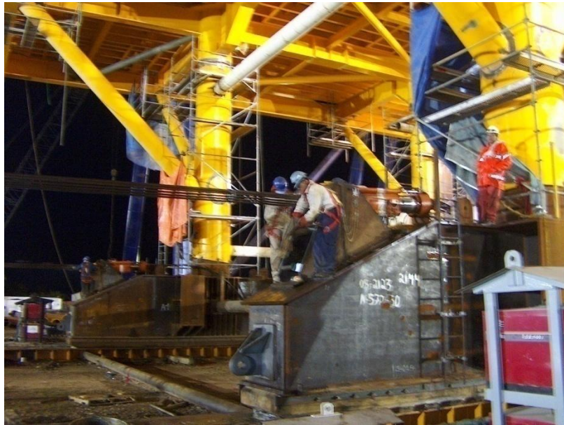
Ilustración 14. Sistema de arrastre y empuje de la estructura
