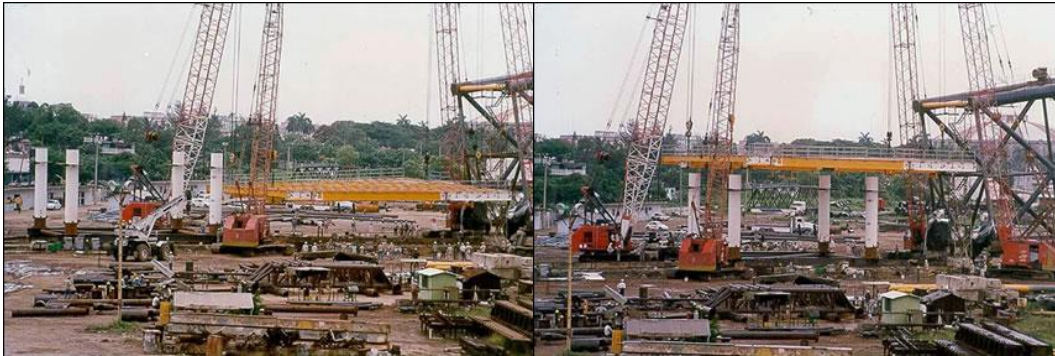
Ilustración 12. Izaje de la cubierta inferior de una superestructura
