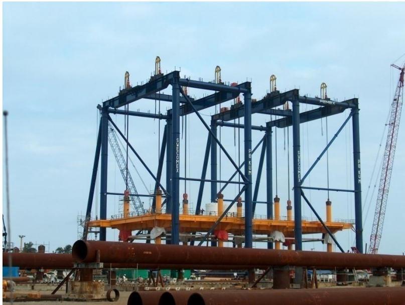
Ilustración 5. Pórticos simétricos de estructura metálica
