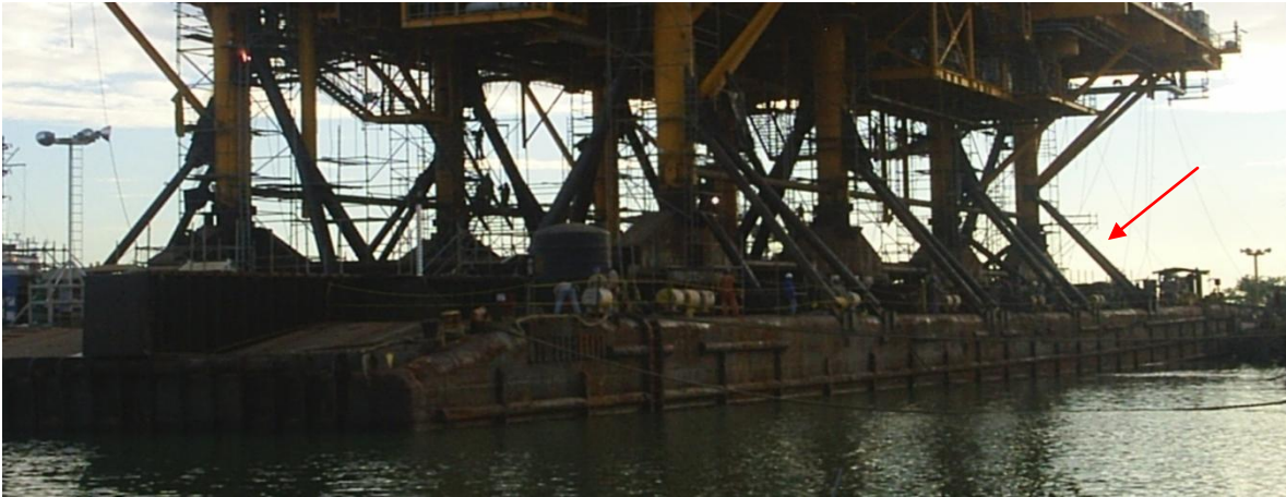
Ilustración 24. Seguros marinos para el transporte de una superestructura en un chalán
