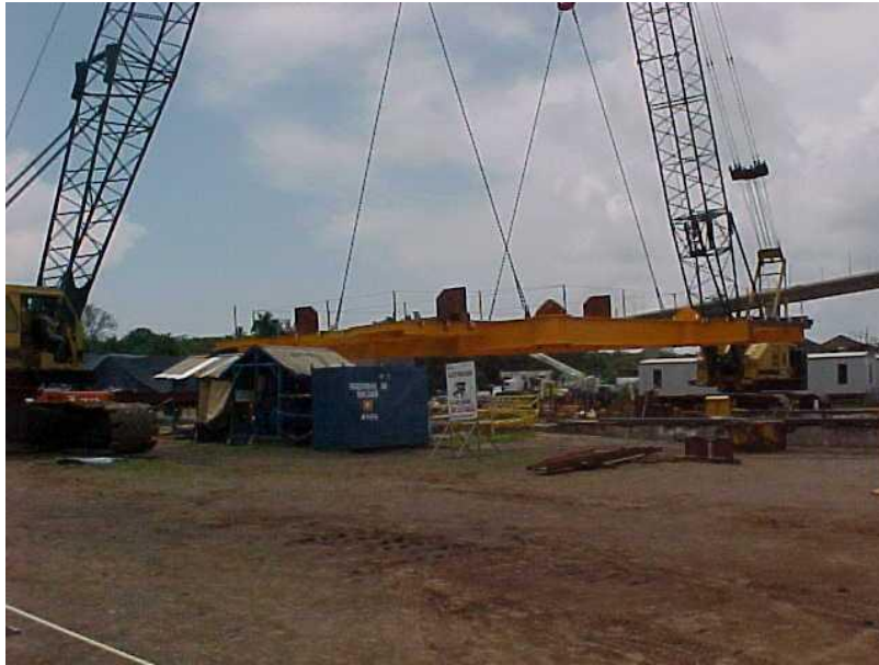
Ilustración 32. Inicio del izaje de la cubierta
