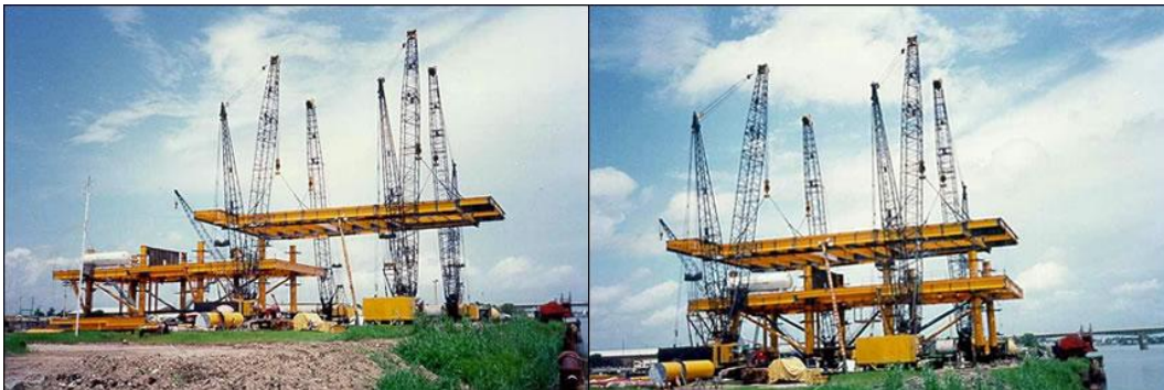
Ilustración 13. Izaje de la cubierta superior de una superestructura
