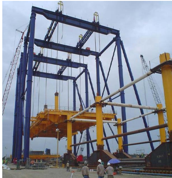
Ilustración 1. Pórtico de izaje
