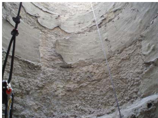
Fig. 3.19. Daños en pared de la lumbera 12.
