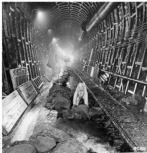
Fig. 1.5. Construcción del Emisor Central.
