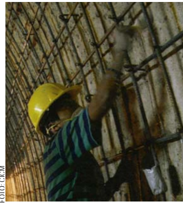
Fig. 3.32. Limpieza del acero expuesto y armado del acero de refuerzo.
