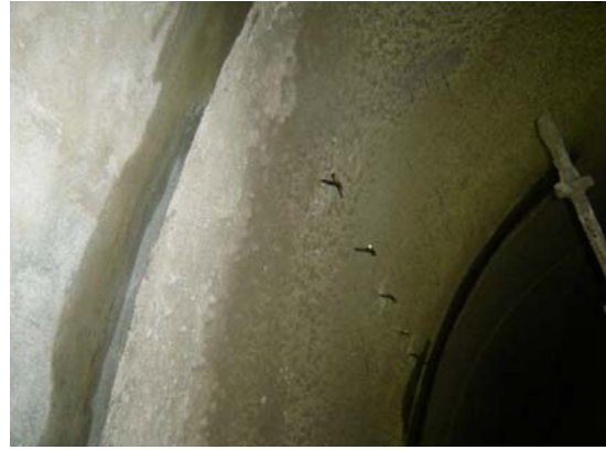
Fig. 3.30. Colocación de anclas en forma de cruz de \frac{1}{2} ", tramo lumbrera 7.
