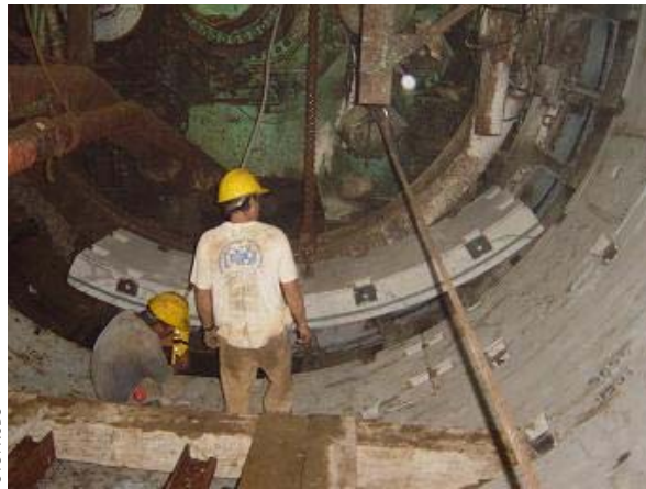
Fig. 1.11. Colocación de dovelas.
