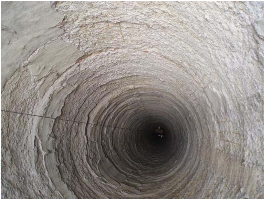
Fig. 1.33. Daños en el revestimiento de concreto de la lumbrera 12 del Emisor Central.
