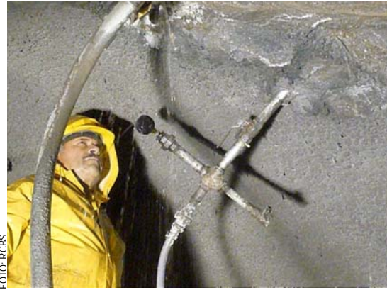
Fig. 3.38. Colocación de boquillas para inyección.
