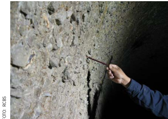
Fig. 3.16. Daños en paredes del túnel.
