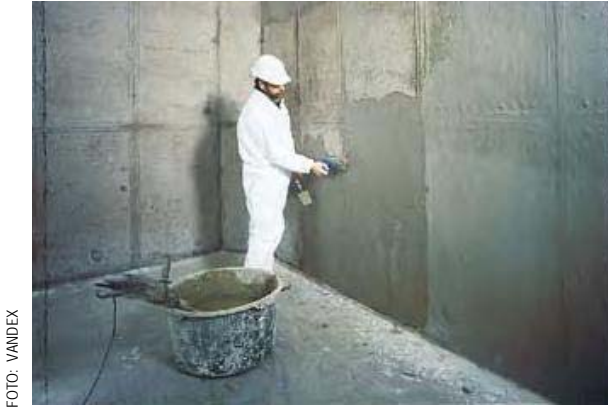
Fig. 3.43. Aplicación con llanas.
