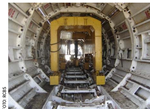
Fig. 1.14. Cimbra telescópica, vista interior.
