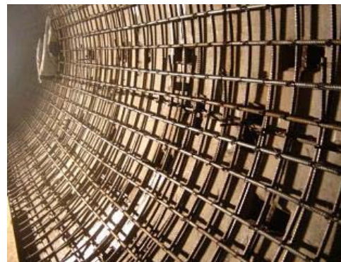
Fig. 1.13. Interceptor Oriente-Oriente, armado de túnel con varilla de acero.
