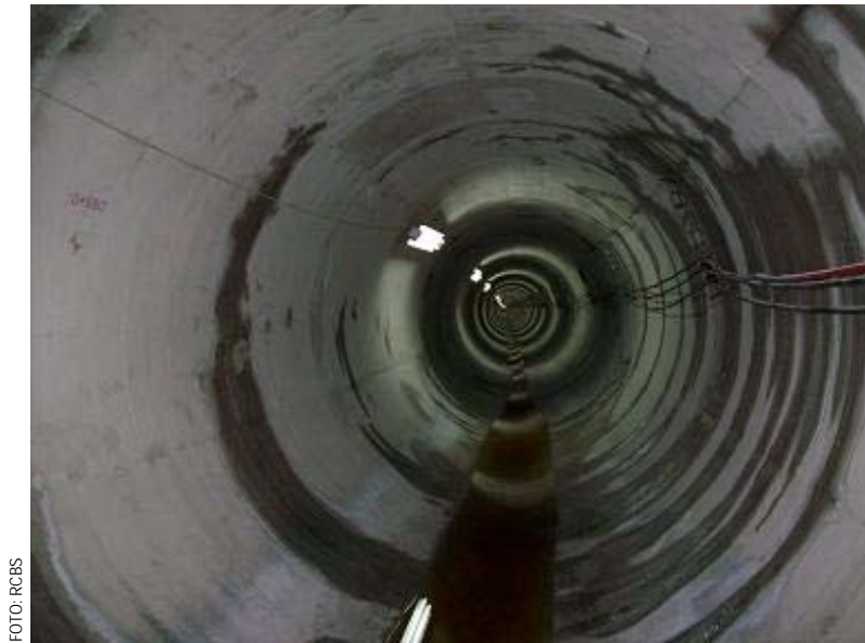
Fig. 1.16. Revestimiento definitivo.
