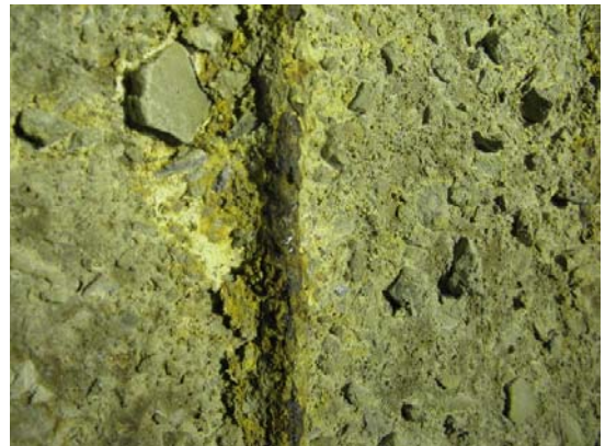
Fig. 3.17. Daños en cubeta de túnel.
