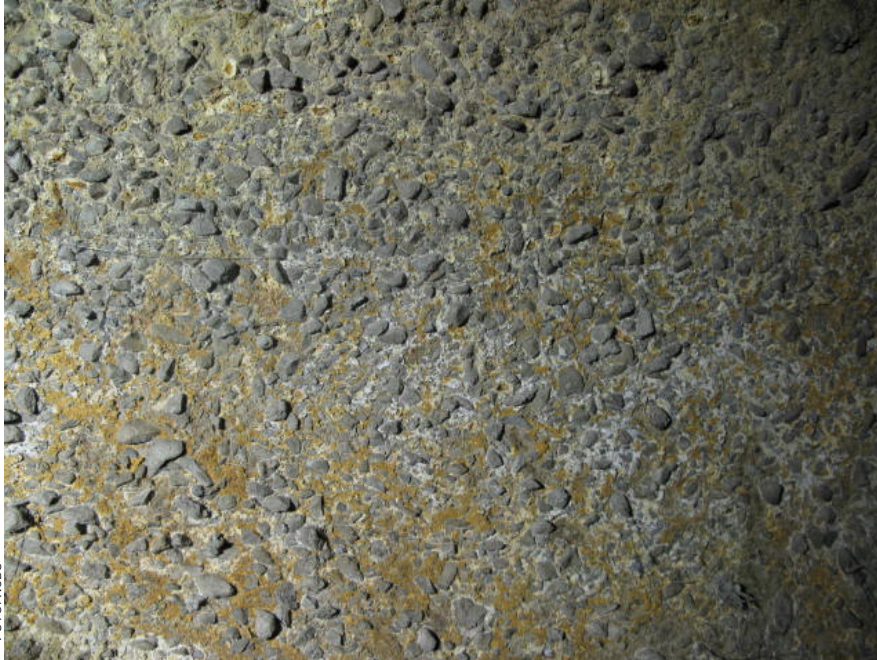
Fig. 1.31. Deterioro del revestimiento de concreto en la lumbrera L-21 del Emisor Central.
