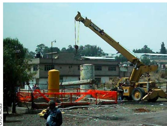
Fig. 3.5. Retiro de tabletas de concreto reforzado en brocal de lumbrera.
