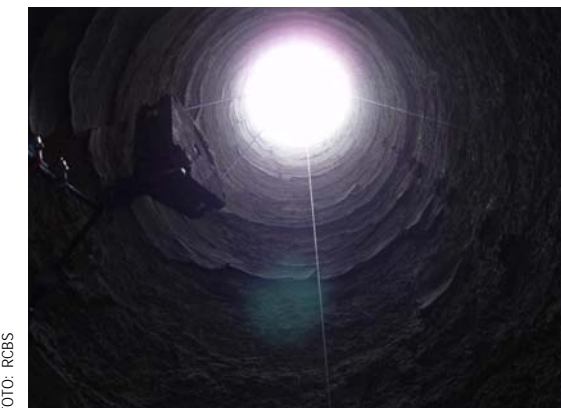
Fig. 3.18. Daños en pared de la lumbera 12.
