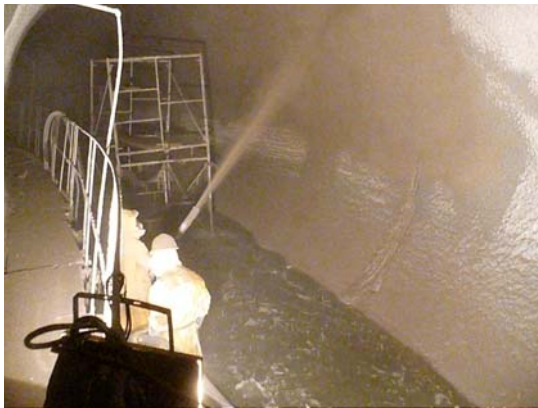
Fig. 3.35. Lanzado de concreto en lumbreira 0.
