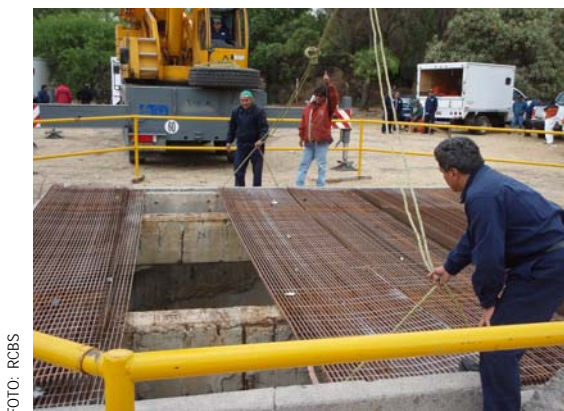
Fig. 3.4. Retiro de rejillas en brocal de lumbrera.
