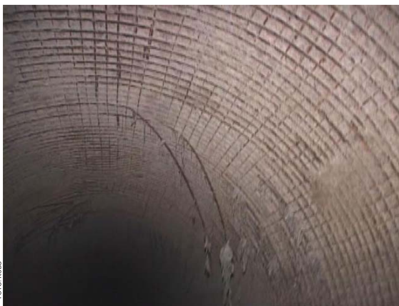
Fig. 1.29. Acero expuesto en la lumbrera L-1 del Emisor Central.
