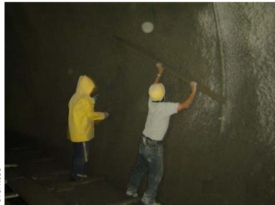
Fig. 3.36. Pulido del concreto lanzado en lumbreira 6.
