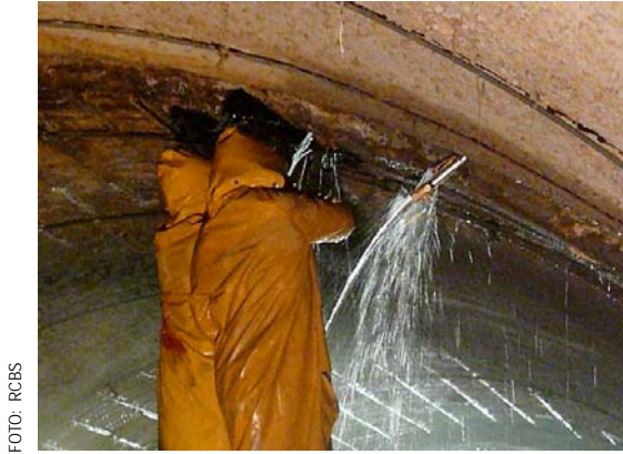
Fig. 3.37. Canalización e inyección de contacto.
