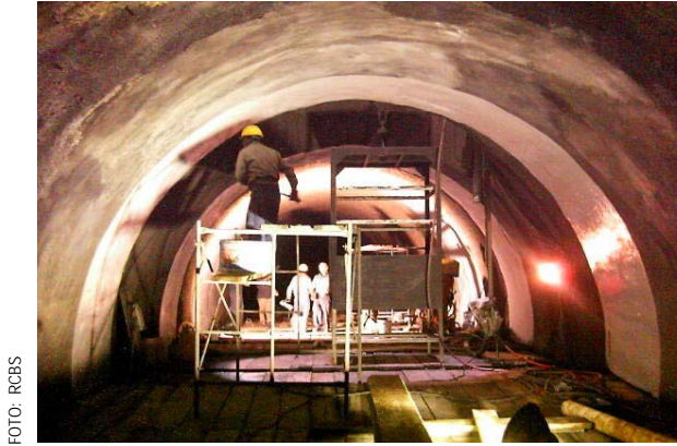
Fig. 3.39. Impermeabilización con epóxico, tramo lumbrera 19.
