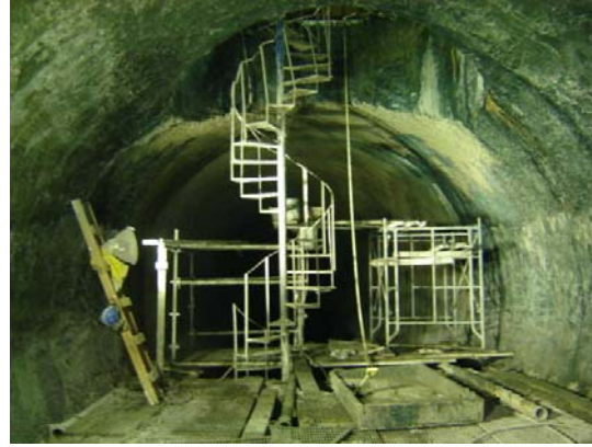
Fig. 3.27. Instalación en tramo lumbrera 3.
