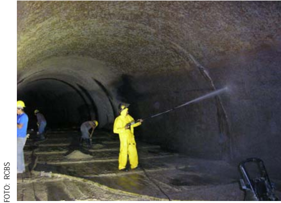
Fig. 3.29. Limpieza con agua a presión con equipo hidroblast, tramo lumbrera 21.
