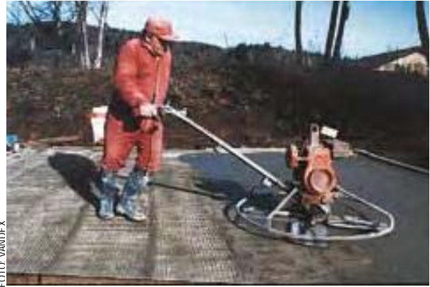
Fig. 3.44. Aplicación con fratasadora.
