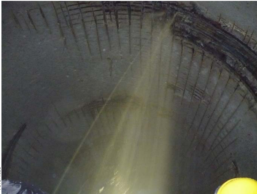
Fig. 1.30. Filtración en la lumbrera L-O del Emisor Central.
