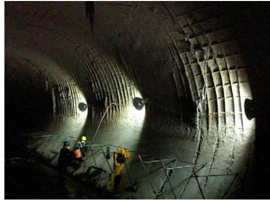
Fig. 3.15. Acero expuesto en túnel, tramo lumbera 6.
