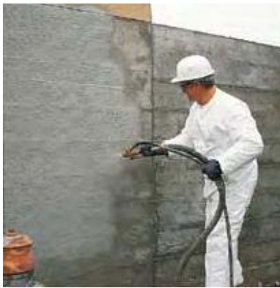
Fig. 3.41. Aplicación a base de inyección.
