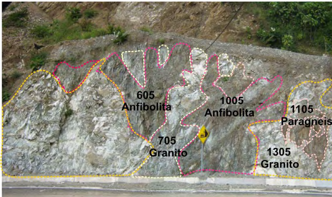
Figura 2.3. Afloramiento en el Km. 14 de la carretera Motozintla-El Porvenir donde se expone el contacto entre las unidades de roca del sector oriental analizadas en el presente trabajo.
