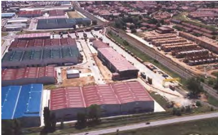
Figura 5. Terminal intermodal de Barcelona, España
