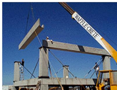
Los paneles modulares pesan la mitad del peso de los paneles sólidos del mismo tamaño. Grúas más livianas se usan para la erección de los paneles. El tiempo usado para levantar un panel es mínimo.
