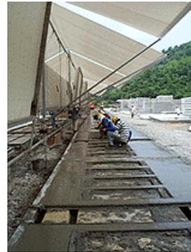
**Preparación y llenado simple:** Los paneles son diseñados para darle la mayor distancia entre columnas, el diseño de los paneles se hace con el uso de refuerzo de acero que es muy fácil de preparar y asegurar en el molde. Las sillas especialmente diseñadas para el acero le permiten colocar las barras en su posición sin el uso del sistema tradicional que usa alambre para atar las barras de acero.
