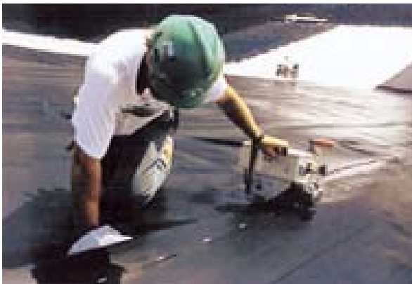
a) Foto donde se puede observar el proceso de termofusión
