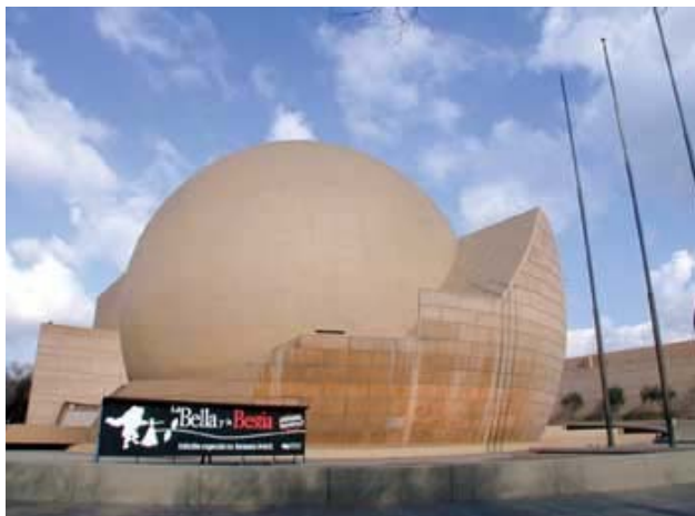
VISTA EXTERIOR DEL EDIFICIO PRINCIPAL
