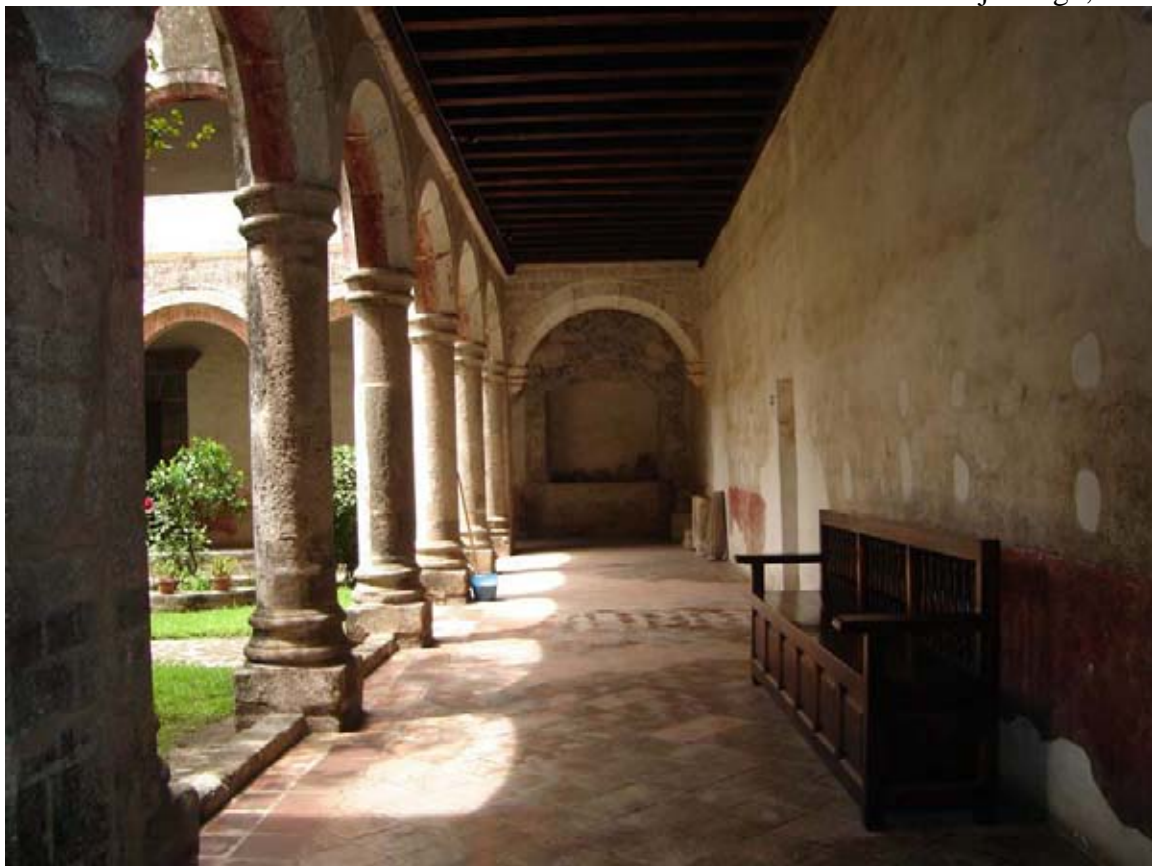
F.42. Claustro: Convento Huejotzingo, Pue.
