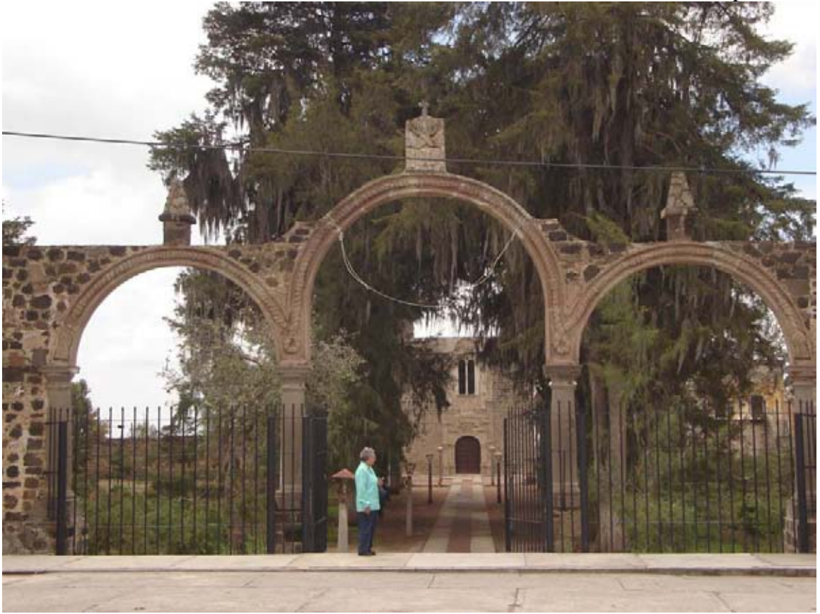
F.13. Entrada al atrio: Convento de Calpan, Pue.
