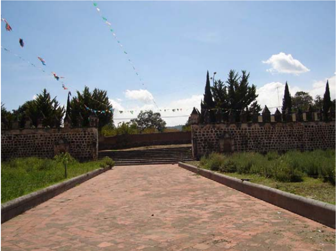
F. 19. Vista de la entrada desde cruz atrial: Convento de Tochimilco, Pue.
