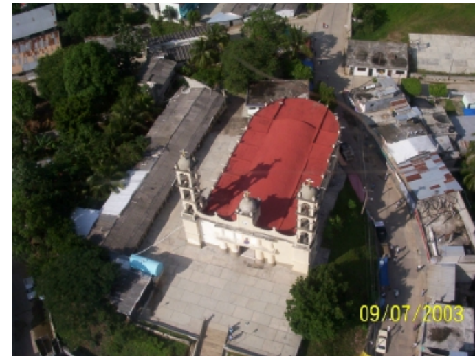
Vista aerea Raudales malpaso espacios publicos Fuente Archivo JP Arquitectos 2003
