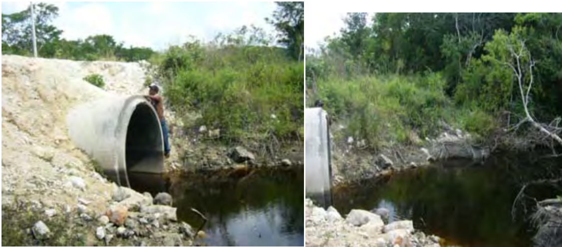
Alcantarillas en la carretera El Escondido Blanca Flor
