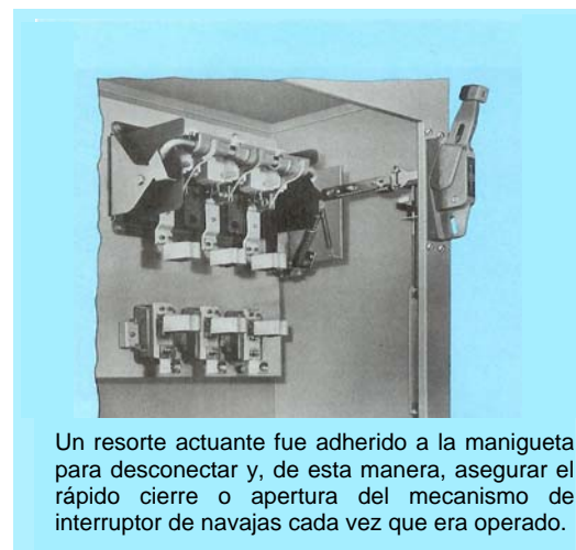
Figura 1.2 Interruptor de navajas con sus respectivas mejoras.
