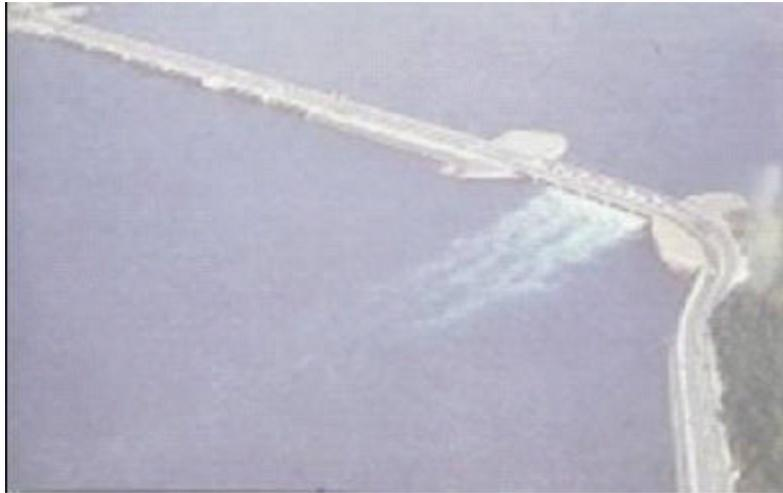
Figura 1.8: Instalación de generación mareomotriz en La Rance Francia
