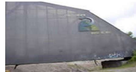
Puente de Fierro
