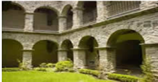
Ex -Convento de San Cristóbal
