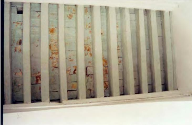
Aula 14. Techo con separación en juntas de ladrillos.
