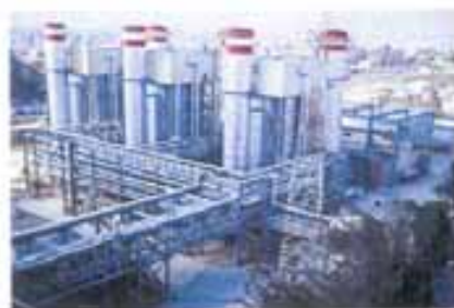
LyFC Termoeléctrica Lechería, DF 224 MW
