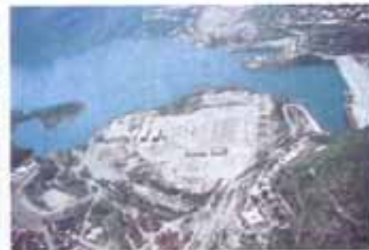
CFE Hidroeléctrica Chicoasén, Chiapas. 2,400 MW
