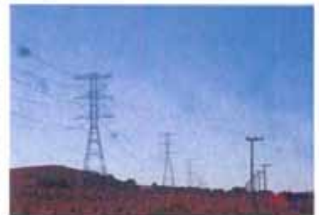
Lineas de Transmision de 400 Kv
