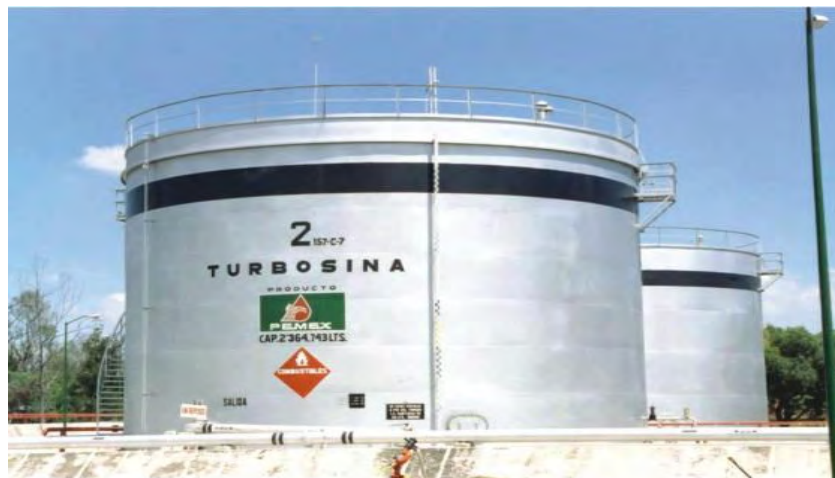
Tanques almacenadores turbosina
