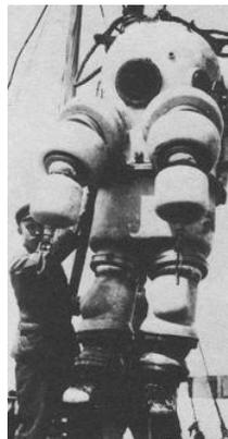
Fig.5. Armadura de buceo “Iron Man”.<sup>1</sup>
