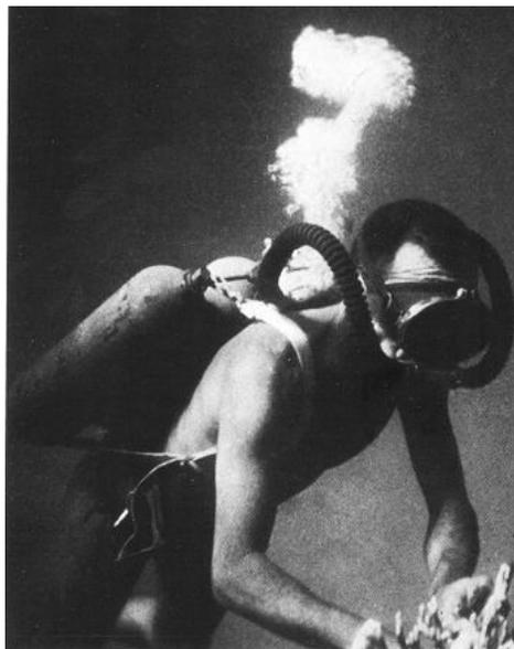
Fig. 6. Primer prototipo del regulador Cousteau-Gagnan.<sup>4</sup>
