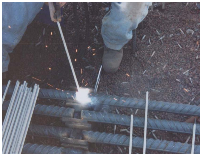
Fig. 2.1 Soldadura de varillas
