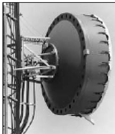
Figura I.8. Antena de microondas.
