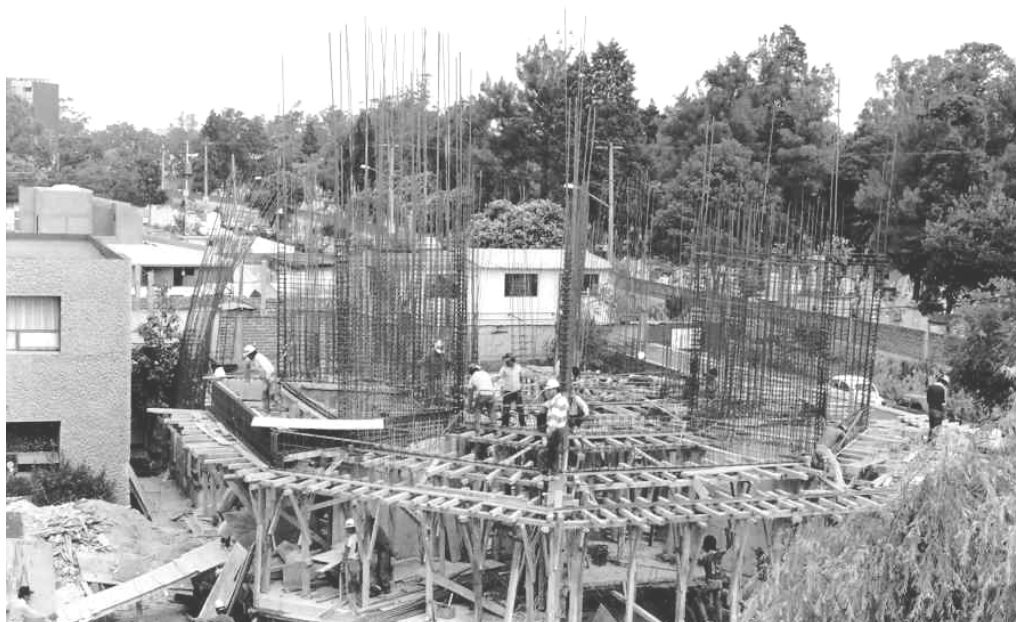
La construcción del IMER en Mayorazgo, colonia Xoco después del temblor del 85. Foto George Carreón.
