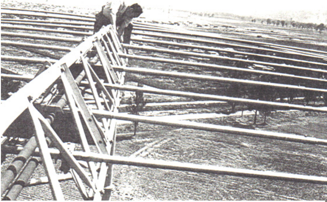
El ingeniero George Carreón arregla la antena direccional descompuesta por una bala perdida. Foto George Carreón.
