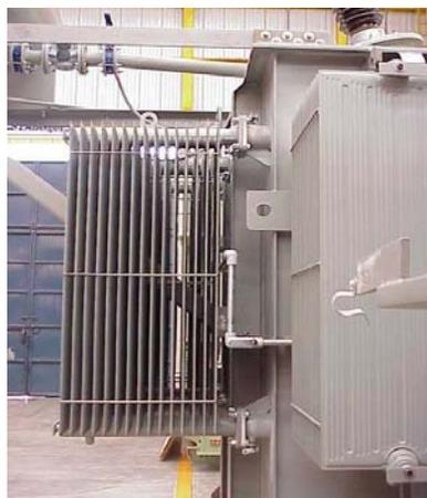
**Fig. No. 47 Detalle de acoplamiento de brida del radiador a válvula de bloqueo de tanque principal**
