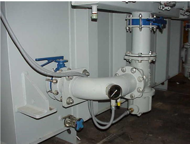
**Fig. No. 22. Motobomba para el sistema de enfriamiento FOA1/FOA2 con su indicador de flujo**
