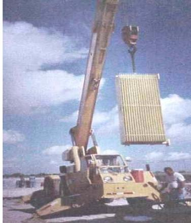
**Fig. 46. Levantamiento para ensamble de radiadores a tanque utilizando grúa.**
