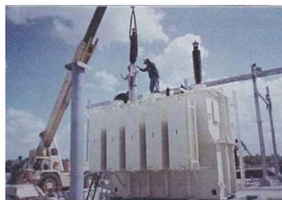
**Fig. No. 49 Método para levantar boquillas**
