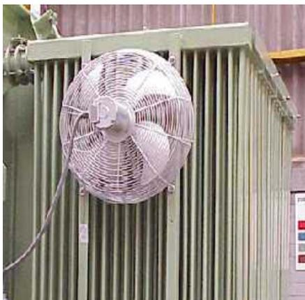
**Fig. No. 48 Detalle de montaje de motoventilador a radiador**
