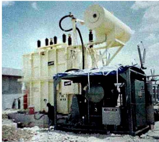
**Fig.54 Foto mostrando una maquina de Vacío Conectada a un transformador.**
