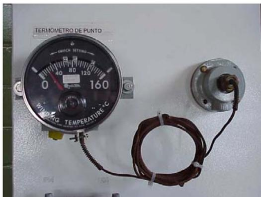
**Fig. No. 26 Indicador del punto más caliente de los devanados con contactos de alarma**
