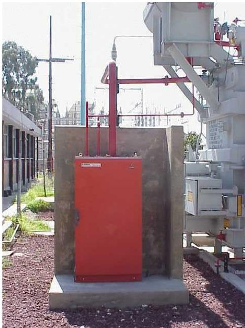
**Fig. No.40. Vista general de la conexión de sistema de prevención contra explosión e incendio.**
