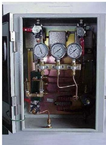
**Fig. No. 34. Partes componentes de un equipo Inert – air.**
