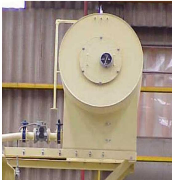
**Fig. 53 Montaje de tanque conservador al tanque principal**
