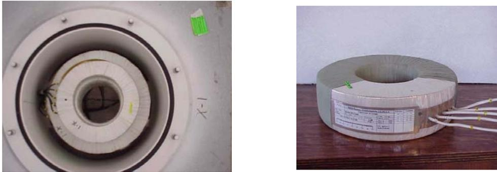
**Fig. No.32. Transformador de corriente tipo Bushing.**
