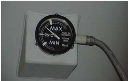
**Figura No.27. Indicador de nivel con contactos de alarma.**
