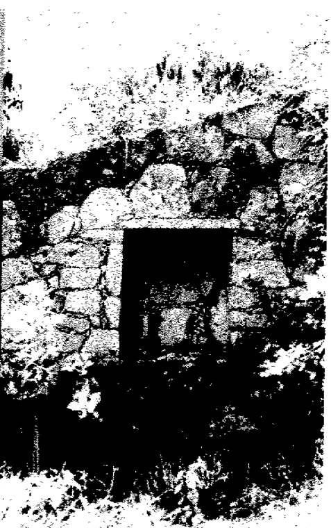
• Muro de tepetate a hueso, lo que implica el labrado de las piedras, con rajuela en junta. El vano (tapiado) se forma con el tratamiento de las aristas de los elementos pétreos.
