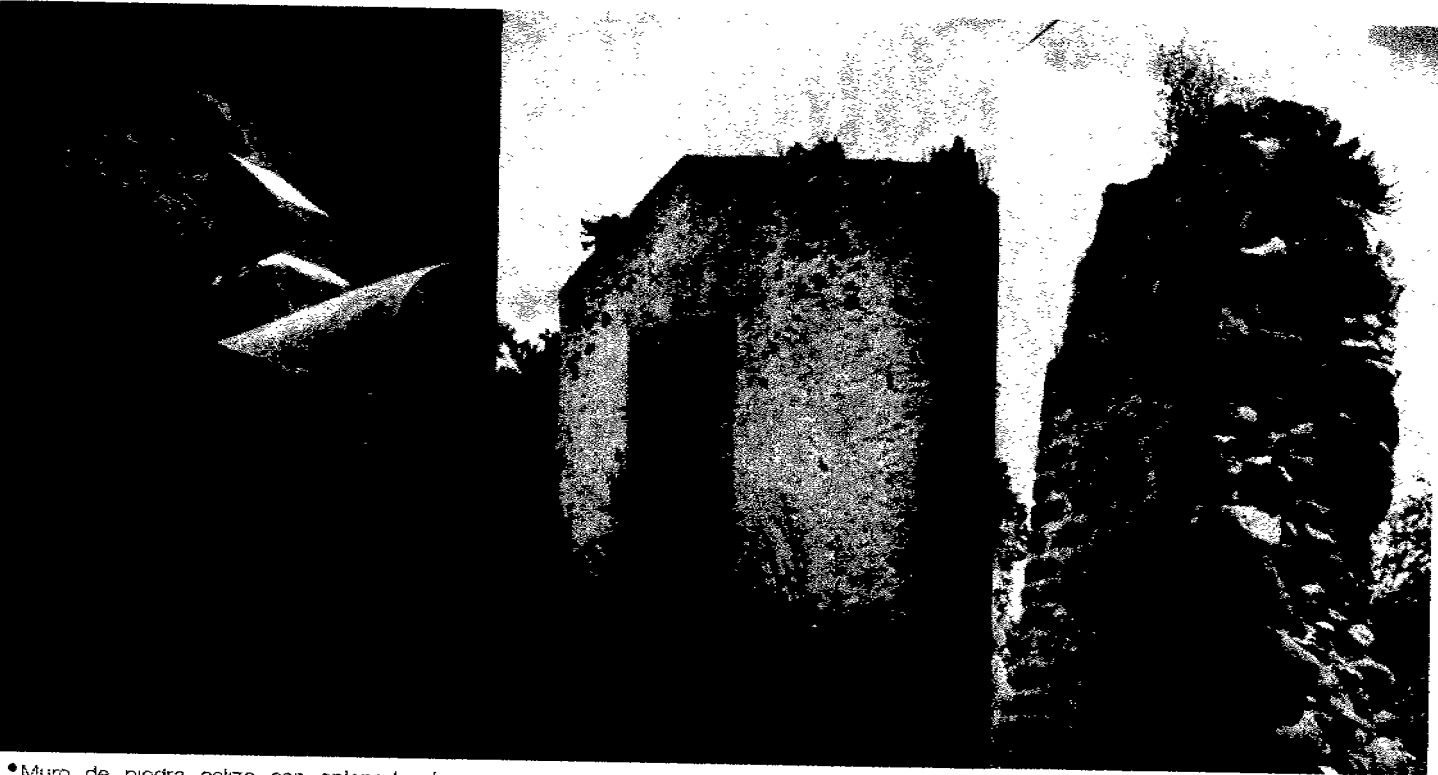
•Muro de piedra brasa con junta seca de adobe. Presenta refuerzos de tabique en los esquineros
