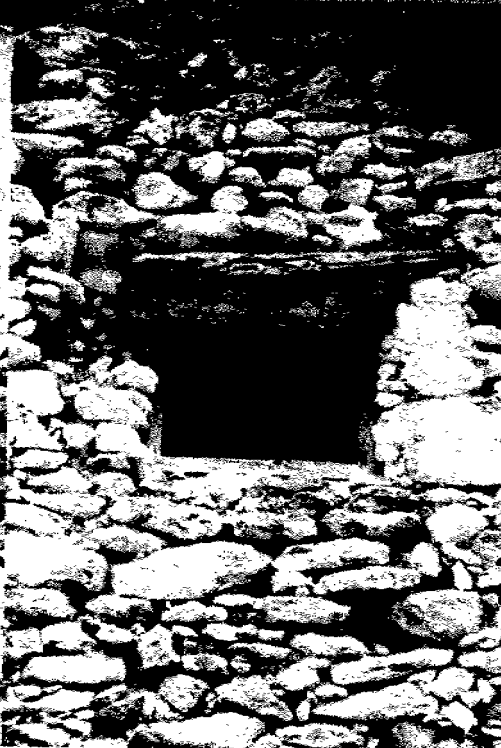
• Muro de piedra caliza con junta de mortero de cal, con pequeña ventana configurada con elementos de madera.
