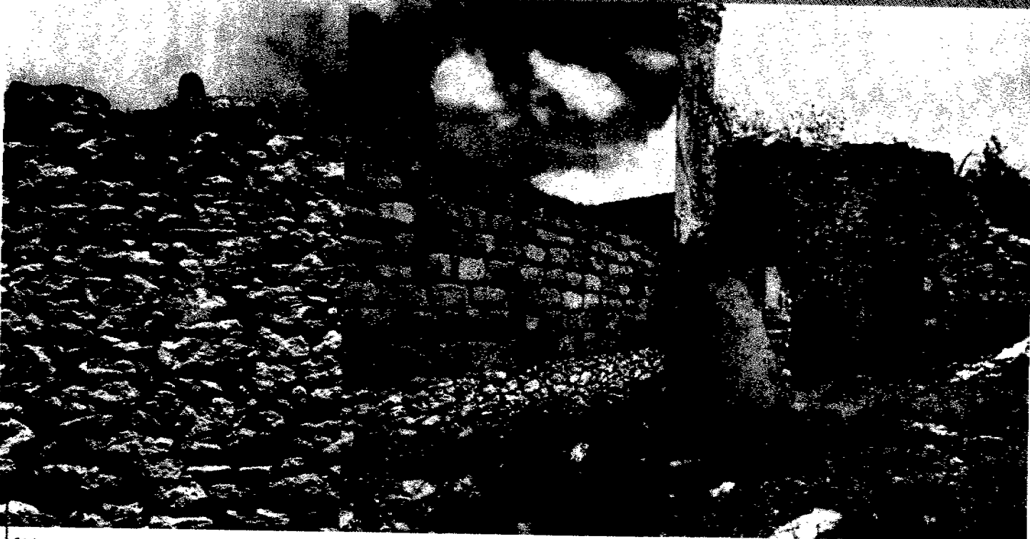
• Muro de vivienda construido con piedra caliza de la región, aplanado de cal.
