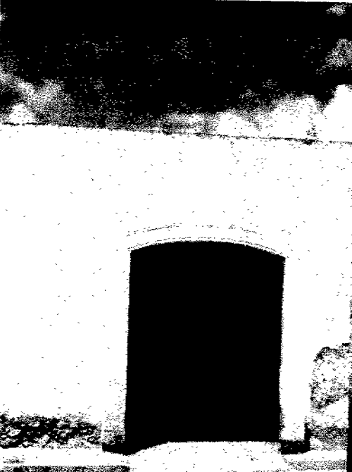
• Piedra caliza con cantos labrados para configurar el vano; muro construido con piedras del mismo tipo sin labrar, junteadas con mortero de cal. Trazos sencillos; texturas y cromática típica de la región.
