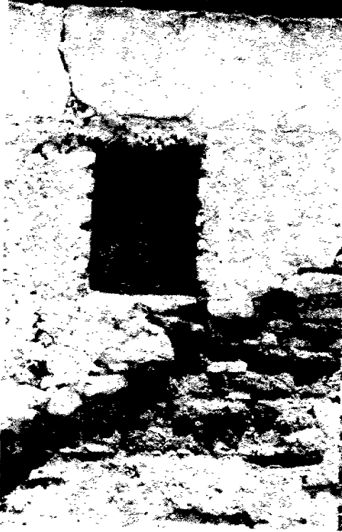
• Pequeña ventana construida con elementos de madera. En muro combinado de piedra y adobe. La única función del vano es la de permitir la ventilación de la vivienda.
