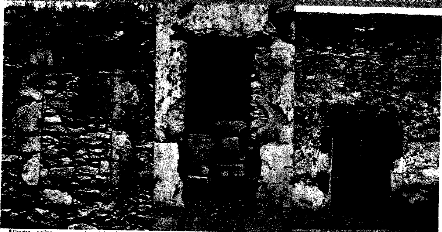
• Arco rebajado sobre vano de acceso, construido con canteras labradas para resaltar el elemento, el muro aparente construido con piedra caliza de la región, con junta de mortero de cal.
