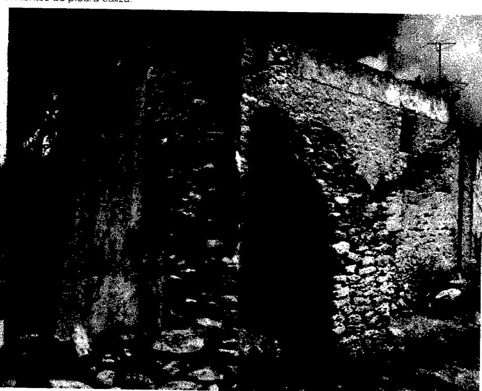
• Muro construido con parte de adobe y de piedra caliza. Como elemento de refuerzo se emplean anchos (70 cm.) contrafuertes de piedra caliza, acabado aparente.
