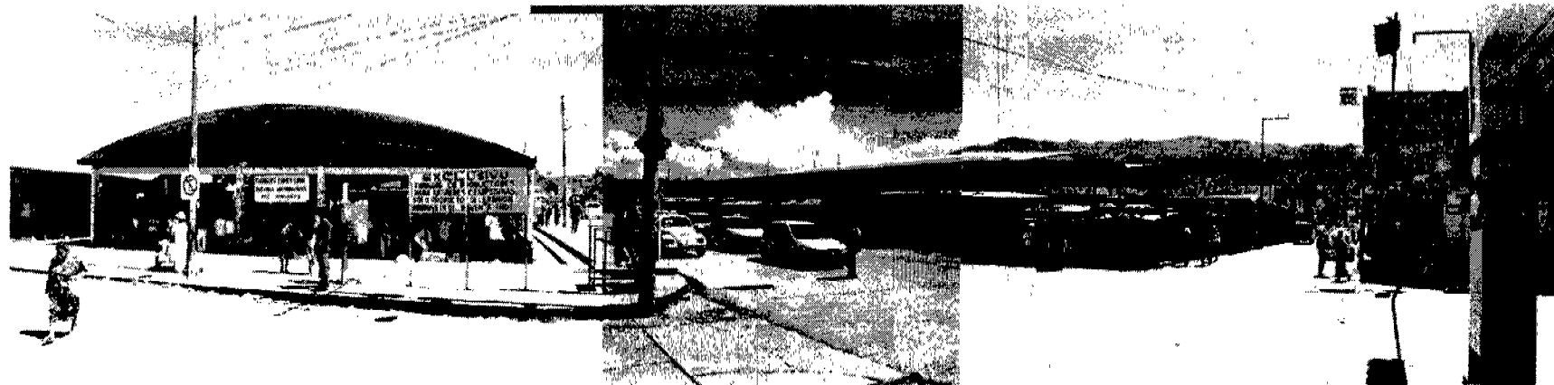
Vista 1: Zona de Abasto y comercio
