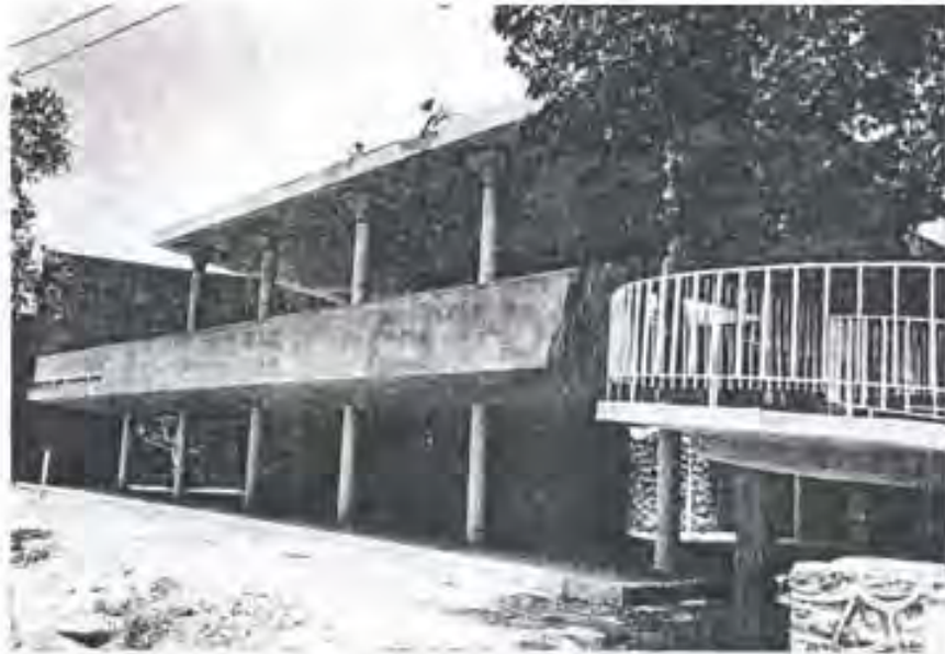
Vista del edificio restaurant de la alberca principal. El acceso a este edificio, así por medio de una rampa suave y en la parte superior habrá servicio de cantina y restaurant, así como lugar para baile. La planta baja la constituye un jardín de sombra con una refresquería.
