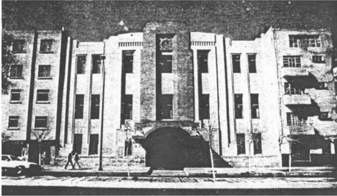
7. Edificio de La Alianza de Ferrocarrileros de México. Arquitectos Vicente Mendiola, Carlos Greenham y Luis Alvarado, 1926.
