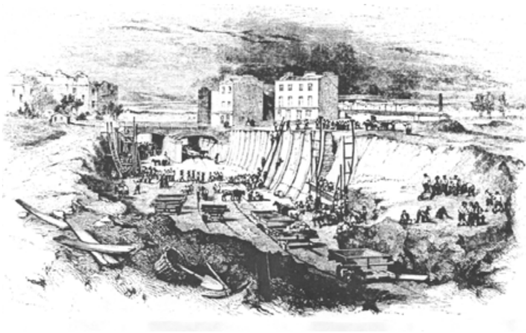
Figura 3 Construcción del Ferrocarril Londres-Birmingham, 1836.
