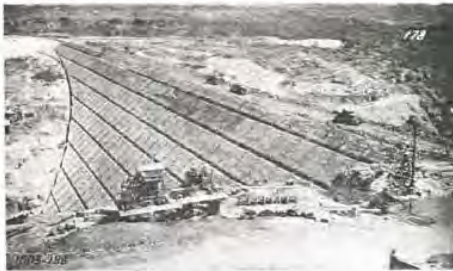
Preso Matamoros. Matamoros.—Preso interior del cerramiento de la sección.
