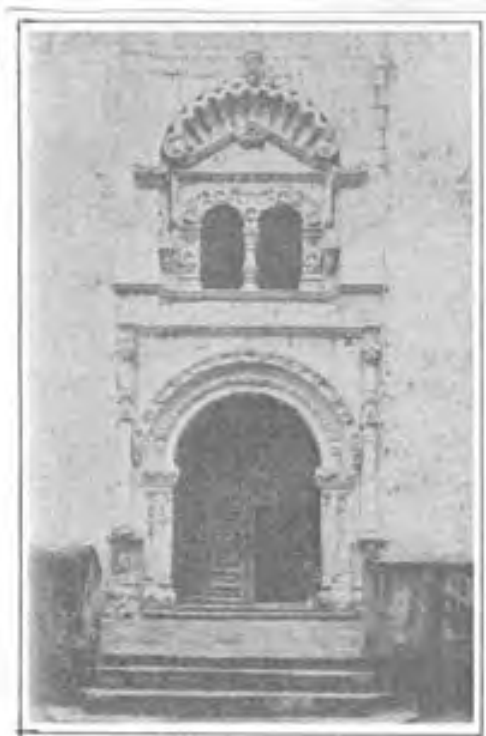
Figura 26 Fachada principal de la iglesia de Tzintzuntzan.
