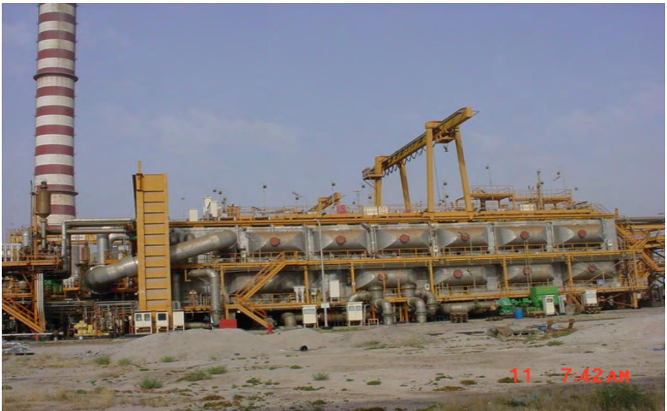
Fig. 13. Planta EIME con recirculación de 24 cámaras (3 en zona de rechazo) y configuración de flujo cruzado; con una capacidad de producción de 27240 m<sup>3</sup> de agua dulce/día, ubicada en Doha West, Kuwait.
